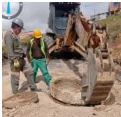
Instalación de tapa para pozo de inspección con retroexcavadora
