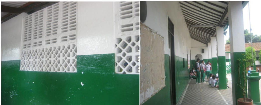
Figura 10. Estado actual de la Institución educativa. Ventanas y Pasillos
