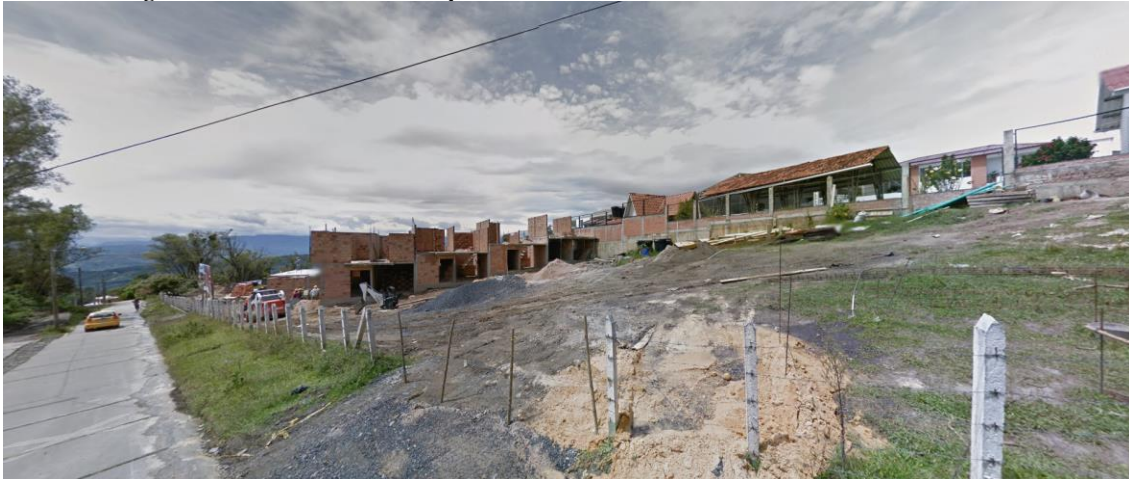
Figura 22. Imagen de urbanización en proceso de construcción.
