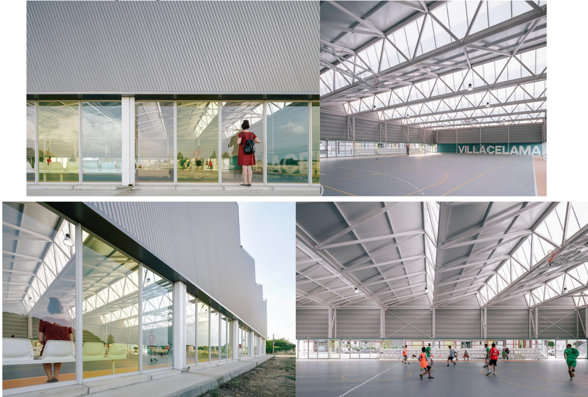
Figura 17. Pabellón polideportivo de Villacelama
