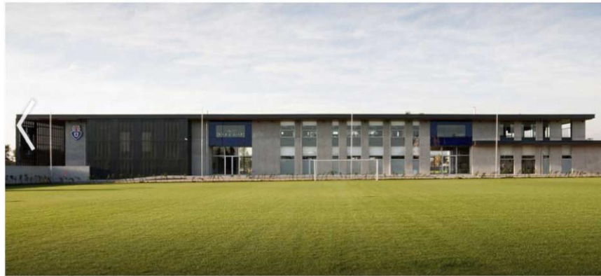
Figura 27. Fachada frontal CDUCH
