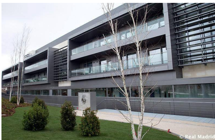
Figura 30. Vista de acceso ciudad deportiva Real Madrid en Valdebebas.
