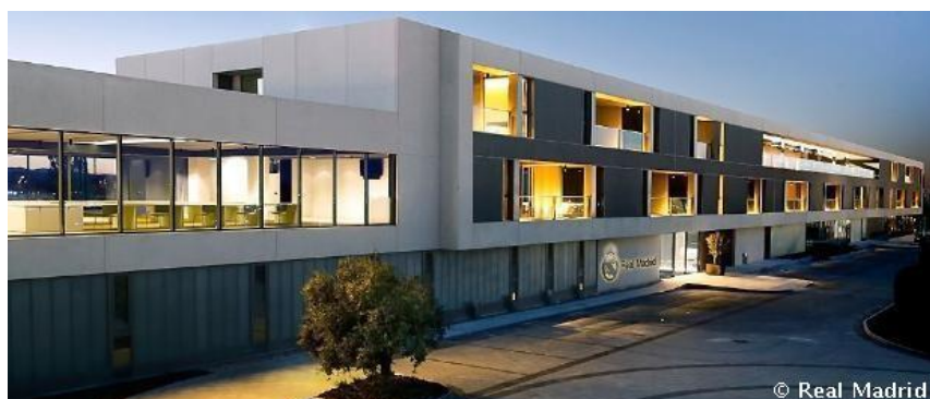
Figura 32. Vista general Edificio “T”
