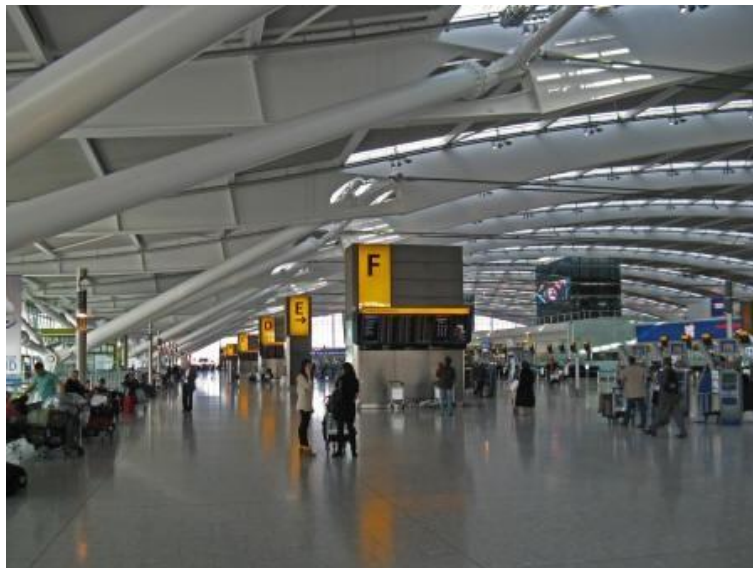
Figura 6. Terminal T5 del Aeropuerto de Heathrow (Londres, 1989-2008)
