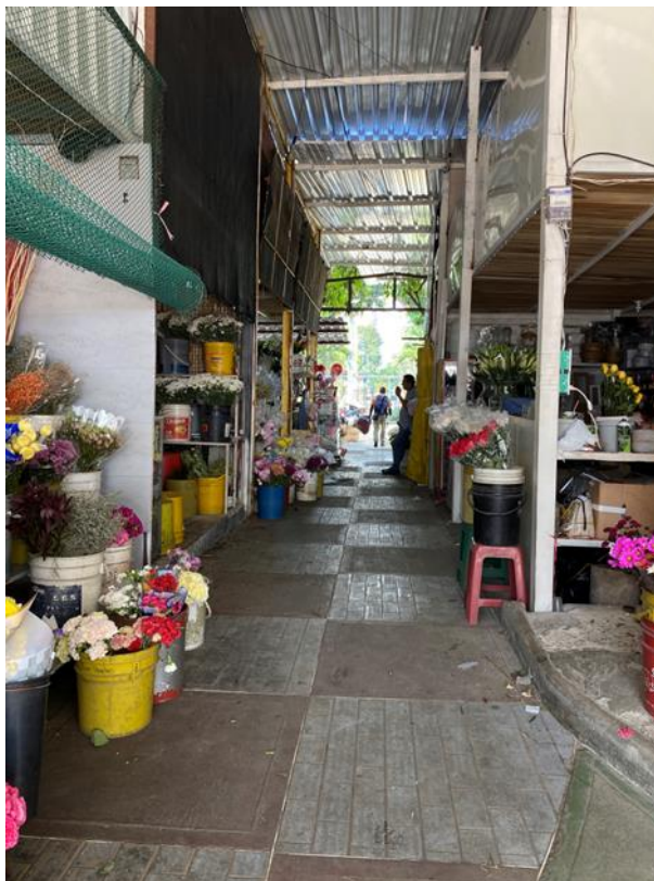
Figura 4. Estado actual senderos peatonales techados informalmente, al interior del Parque Romero
