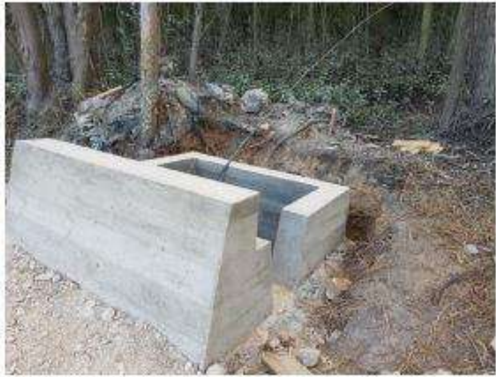
Imagen 2. Alcantarilla tramo pavimento flexible.
