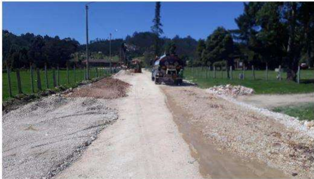
Imagen 3. Construcción pedraplén.
