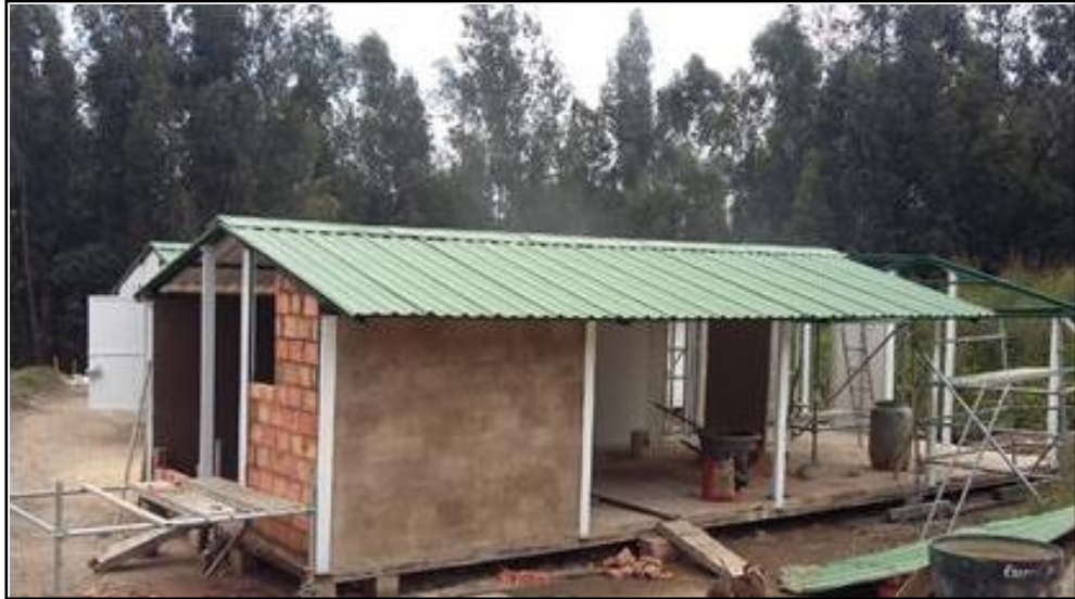
Figura 9. Estructura para el casino, proyecto Mina Santa Martha.
