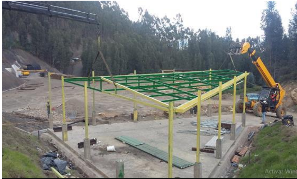
Figura 16. Izaje de cubierta para placa de compresores.
