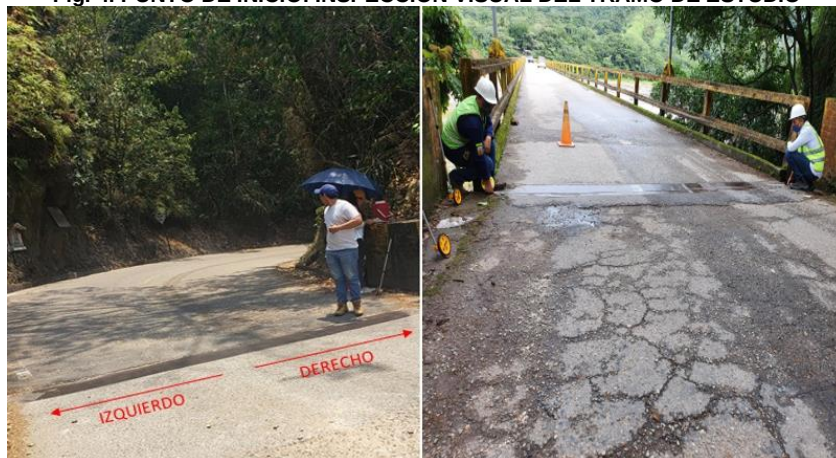
Fig. 4. PUNTO DE INICIO: INSPECCIÓN VISUAL DEL TRAMO DE ESTUDIO
