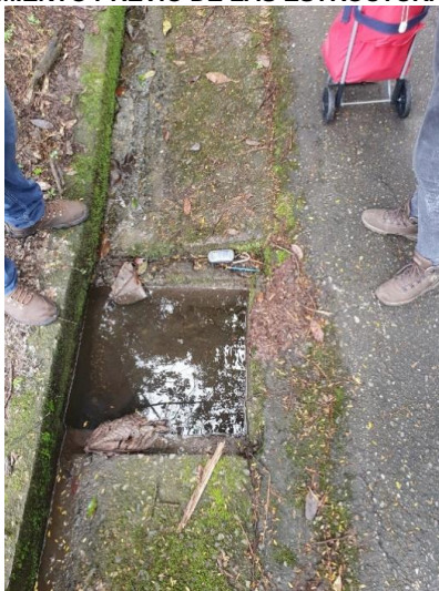
Fig. 7. RECONOCIMIENTO PREVIO DE LAS ESTRUCTURAS DE DRENAJE
