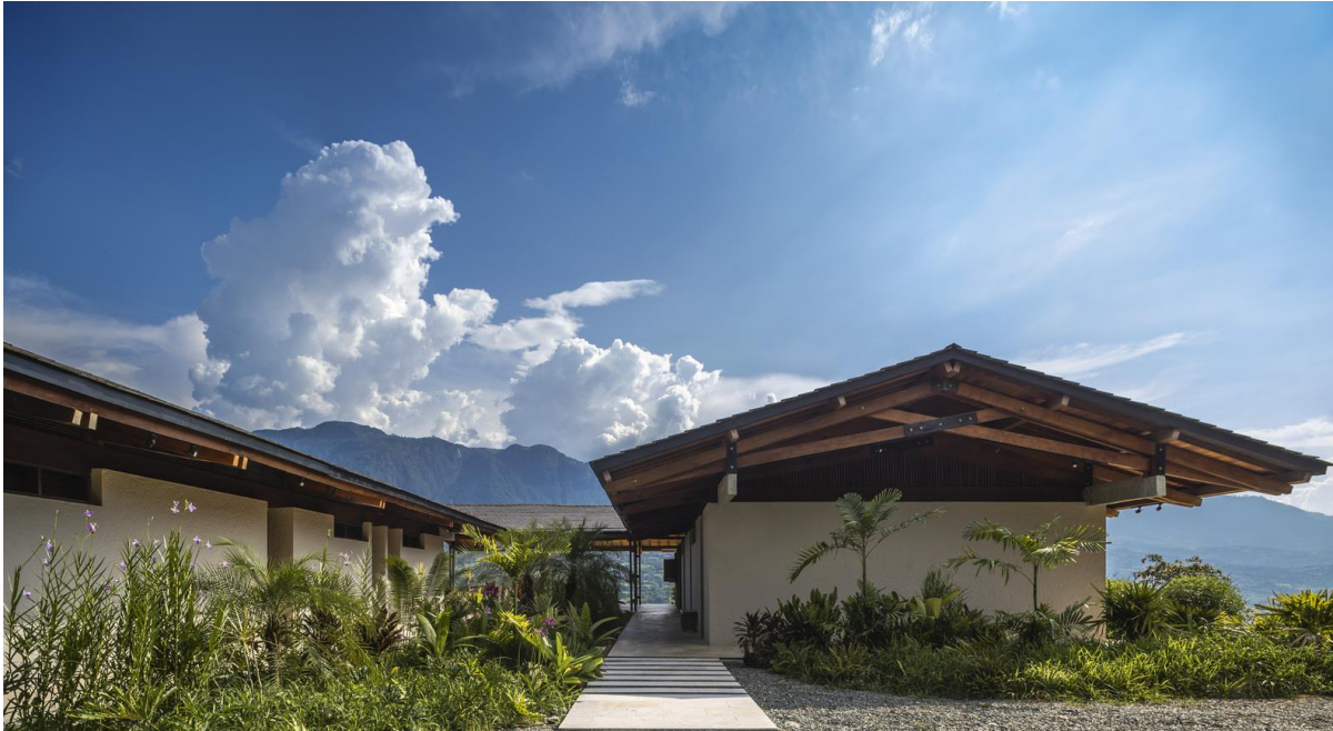
Figura 9. Corredores perimetrales en Casa de Campo en Puente Iglesias.
