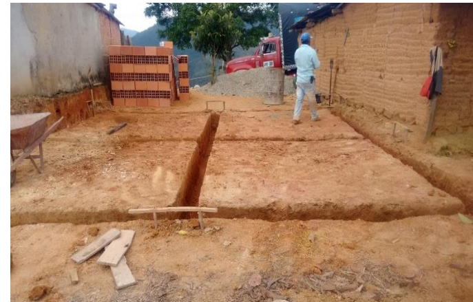
Excavación manual
