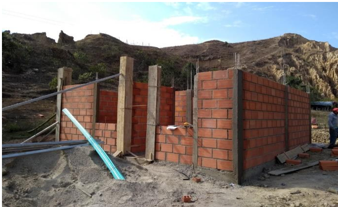
Columnas en concreto
