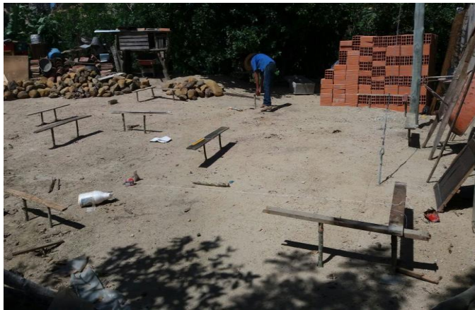
Localización y replanteo
