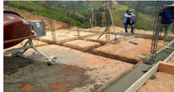
Viga de cimentación
