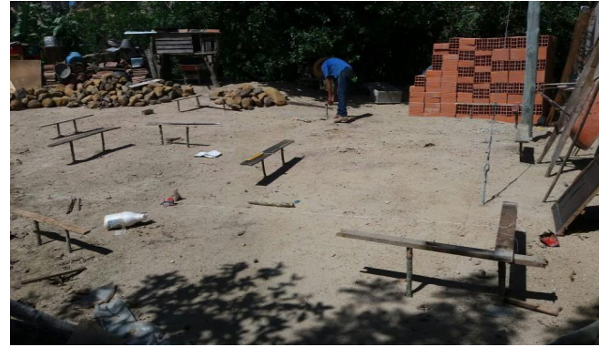
Localización y replanteo
