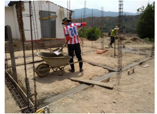
Viga de cimentación
