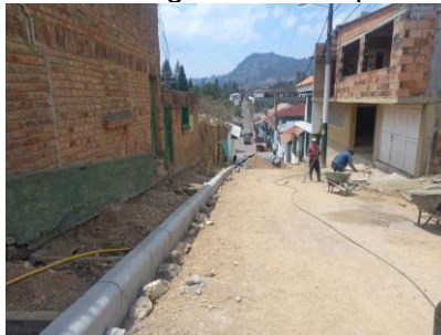
Figura 23. Subbase granular compactada.
