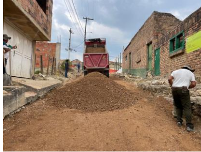
Figura 24. Transporte de material.
