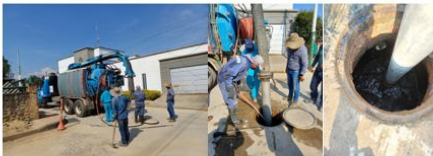
Figura 37. Supervisión y control del vactor.
