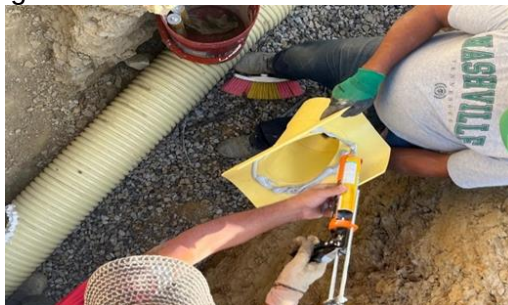
Figura 20. Instalación de silla YEE.
