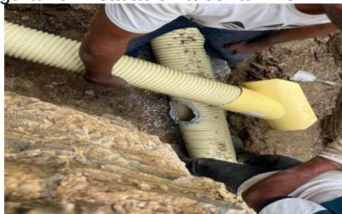
Figura 19. Instalación tubería PVC.
