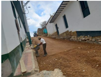
Figura 22. Afirmado compactado con rana y vibro compactador.
