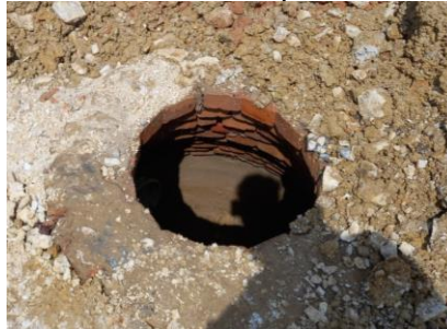
Figura 25. Pozo de inspección.
