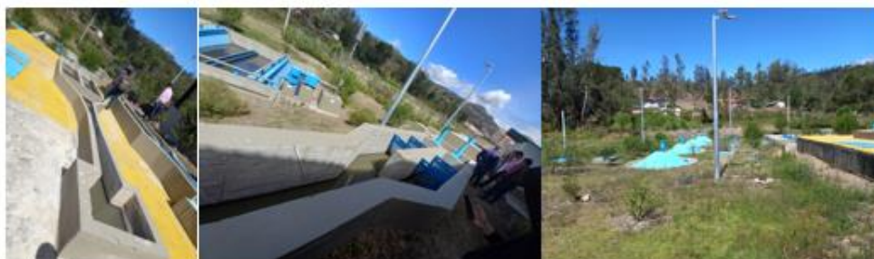
Figura 9. PTAR del municipio de Jenesano.
