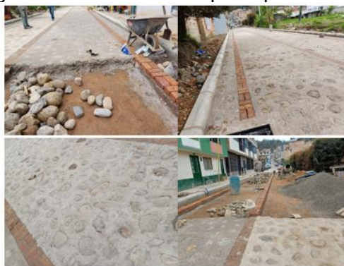
Figura 36. Instalación de pedraplén.
