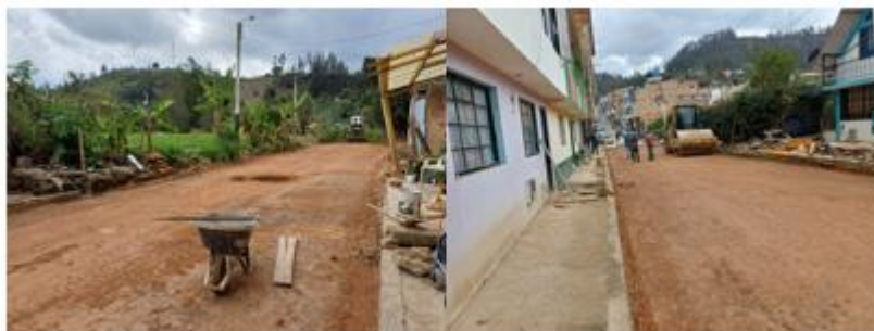
Figura 34. Afirmado compactado con vibro compactador.
