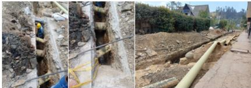
Figura 32. Excavación para la instalación de tubería del alcantarillado.
