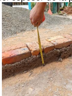
Figura 35. Revisión del espesor de la pavimentación.
