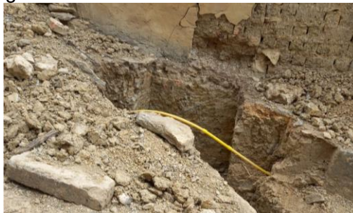
Figura 26. Demolición de andenes.
