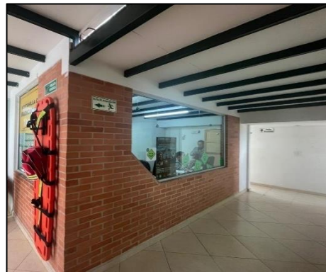
Ilustración 25. MUROS PAT ITBOY COMBITA
