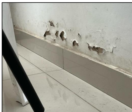
Ilustración 13. MUROS PAT ITBOY NOBSA
