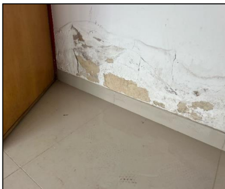
Ilustración 14. MUROS PAT ITBOY NOBSA
