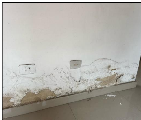
Ilustración 15. MUROS PAT ITBOY NOBSA
