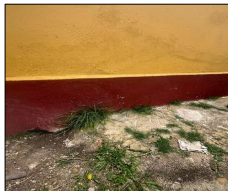
Ilustración 46. FACHADA Vivienda Cuitiva
