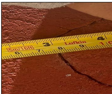
Ilustración 45. FACHADA Vivienda Cuitiva
