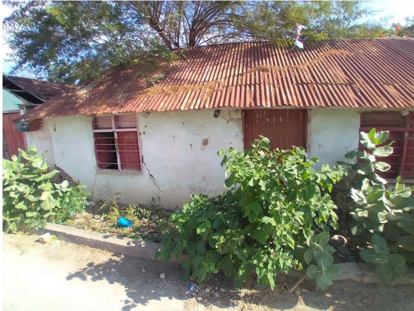
Figura 49. Vivienda en Hatonuevo.
