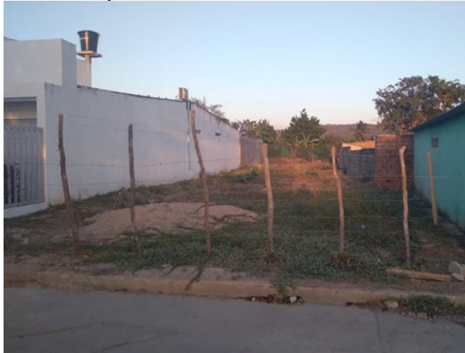
Figura 39. Fachada posterior del predio.
