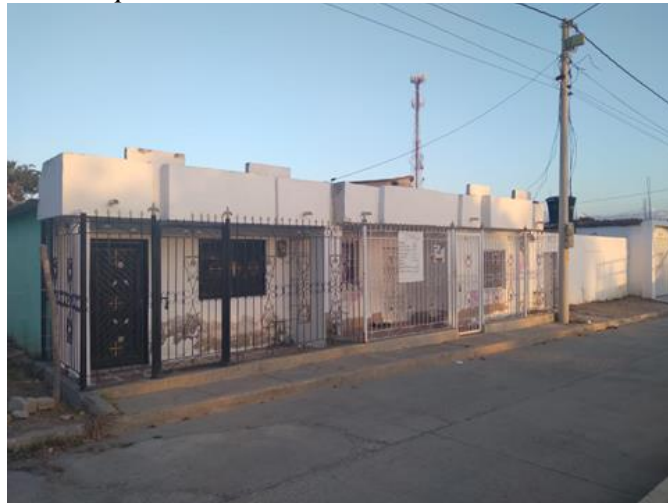
Figura 37. Fachada oeste del predio.
