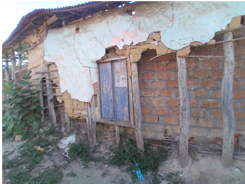
Figura 50. Vivienda en Hatonuevo.
