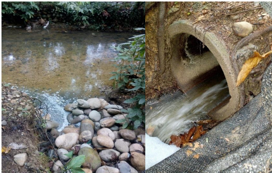
Figura 9. Zona de vertimiento Caño Aguas Claras. Por Daniel, Escobar, 2018
