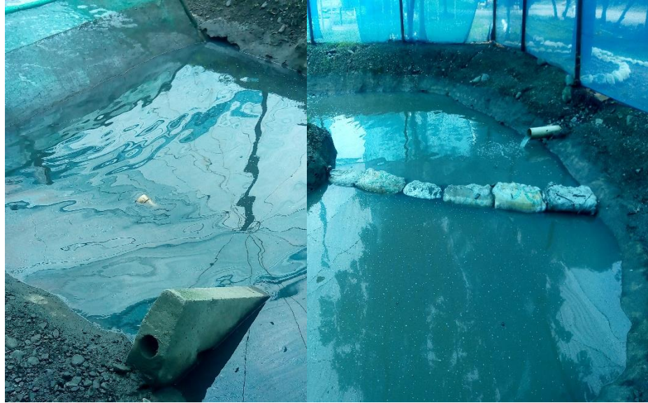
Figura 17. Laguna de Oxidación aireada, Tomada Por Daniel, Escobar, 2018
