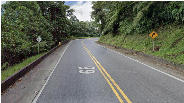
Figura 27. Vista de un tramo de la vía de Bucaramanga a Berlín
