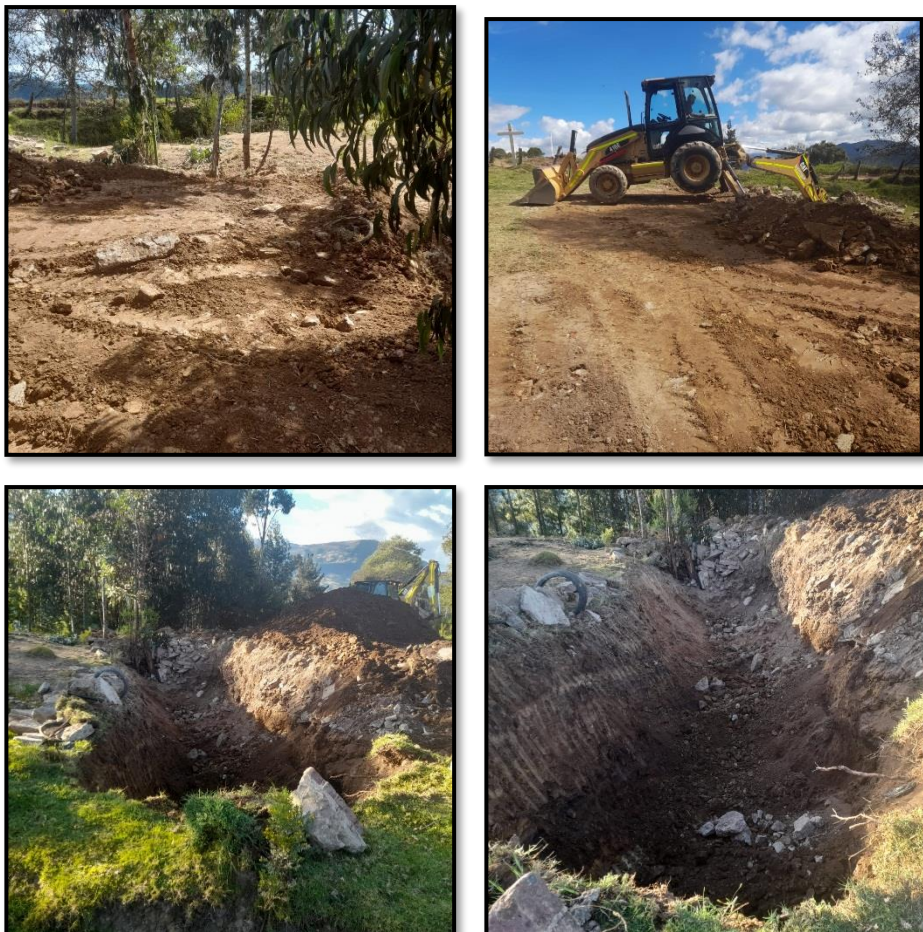
Figura 12. Pozo para tanque plástico Sector Sinai.
