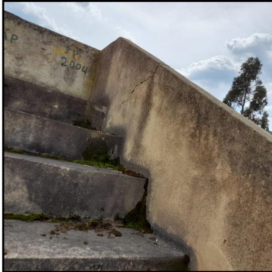
Figura 13. Visita a Obra Sector Rural.
