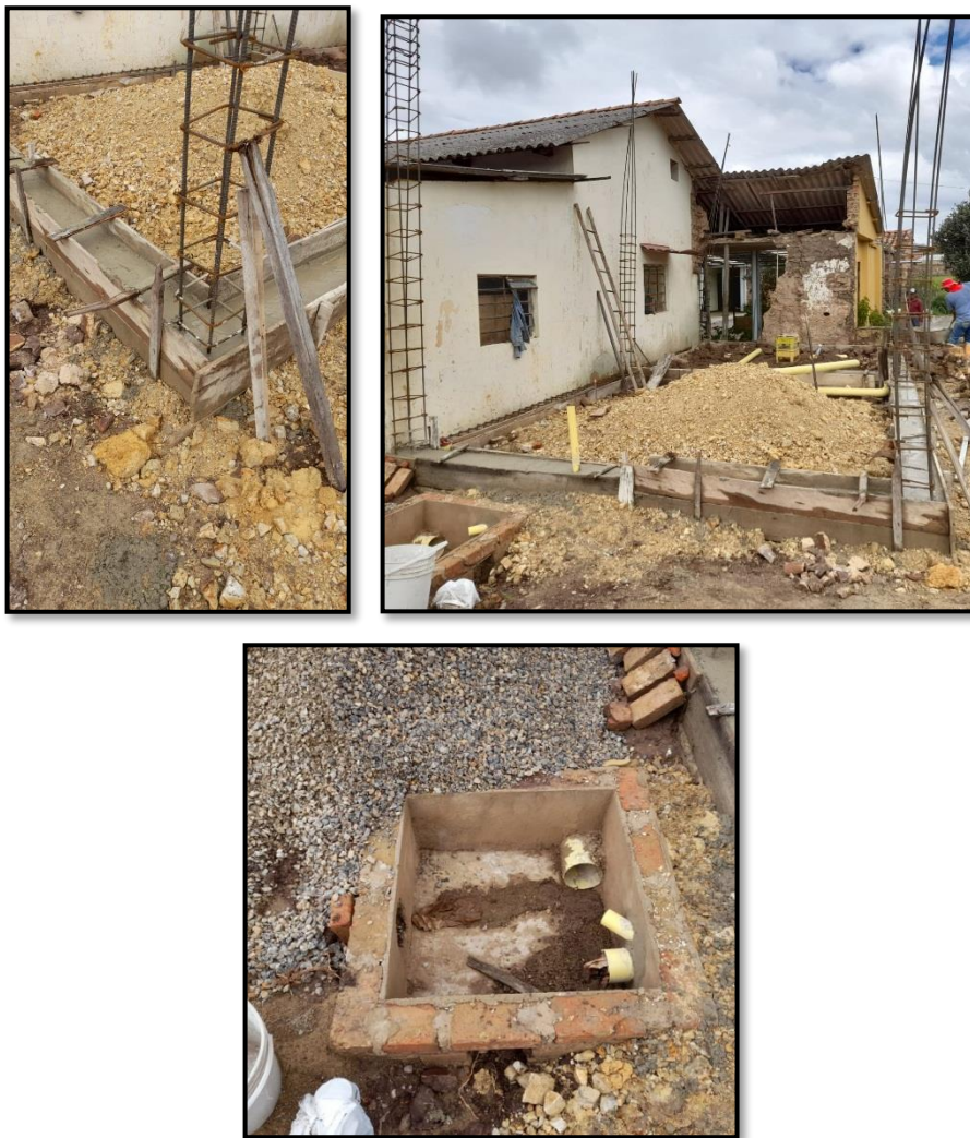
Figura 6. Visitas a obras en ejecución.
