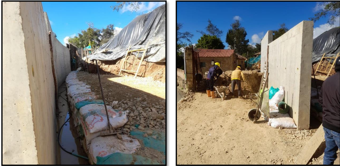
Figura 5. Visita a Obra, muro de contención.
