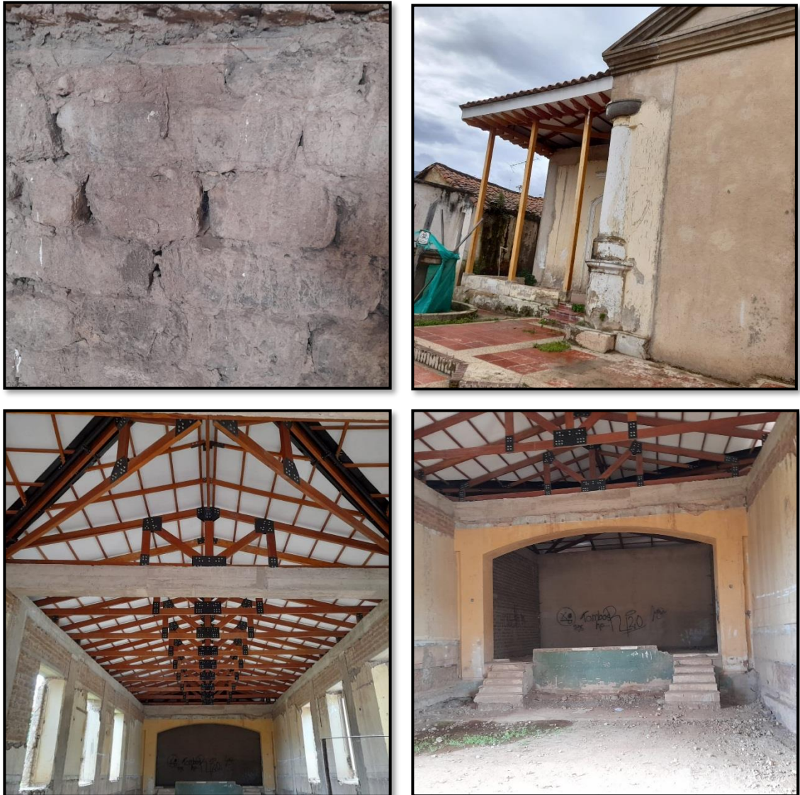
Figura 16. Visita a Obra, Teatro Municipal.
