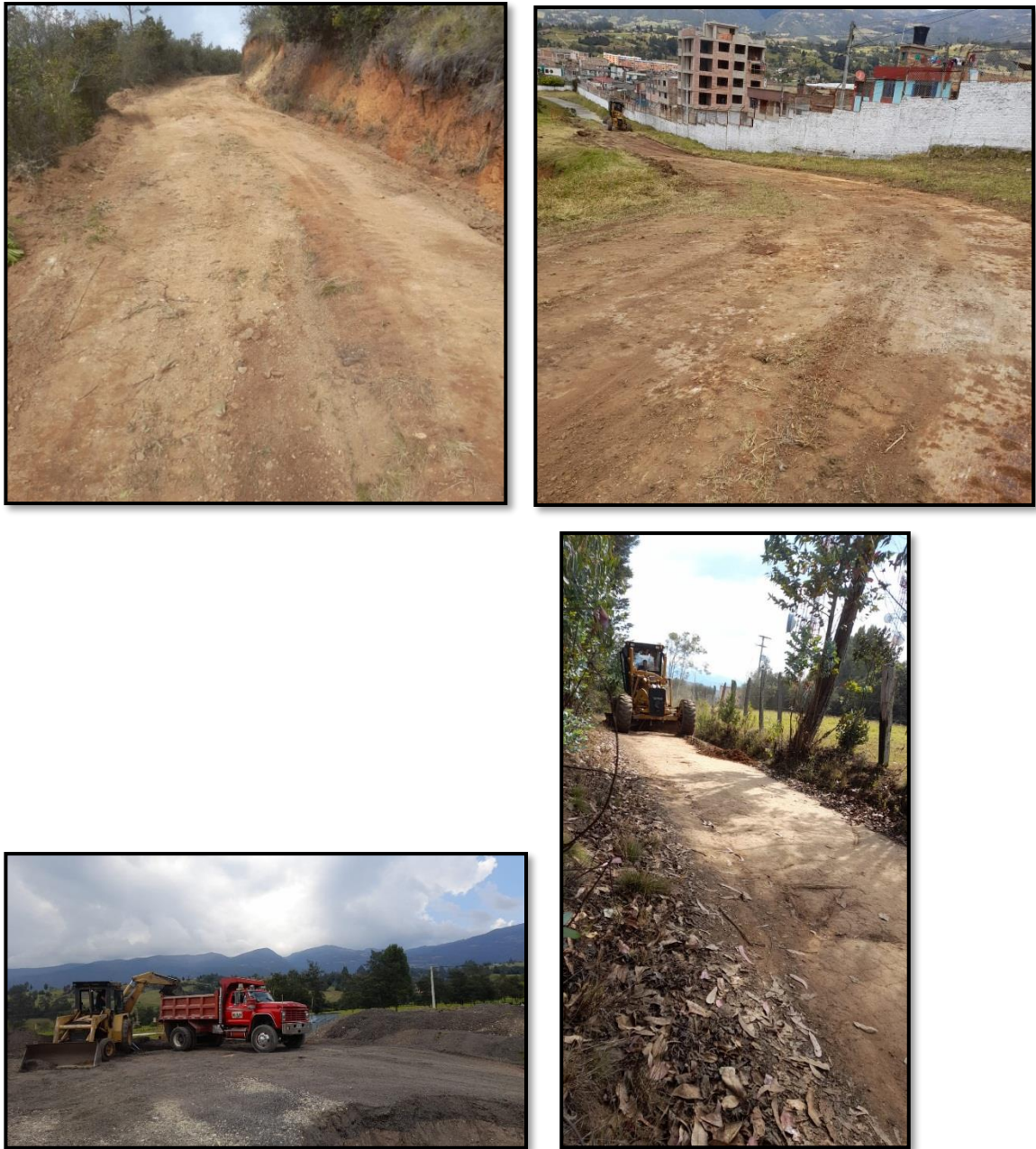
Figura 14. Visita a Obra, mantenimiento vías Rurales.
