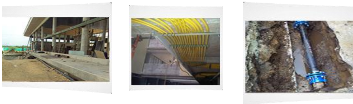
Figura 9. Tuberías para obra urbana
