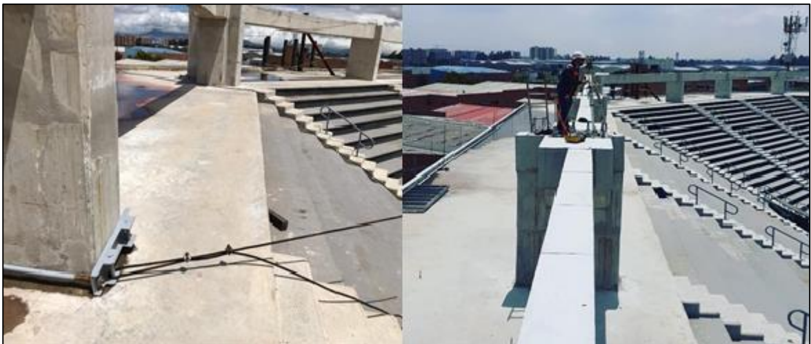
Figura 6. Visitas de campo a proyecto Arena Bogotá.
