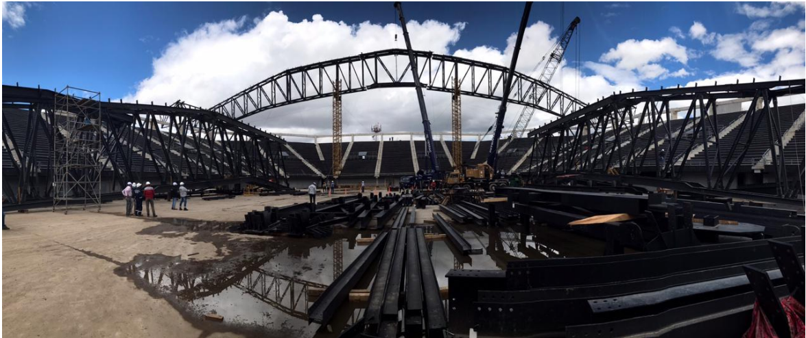
Figura 26. Armado de tramo C
