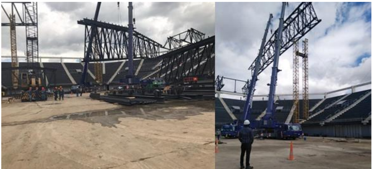
Figura 36. Obra Arena Supervisada
