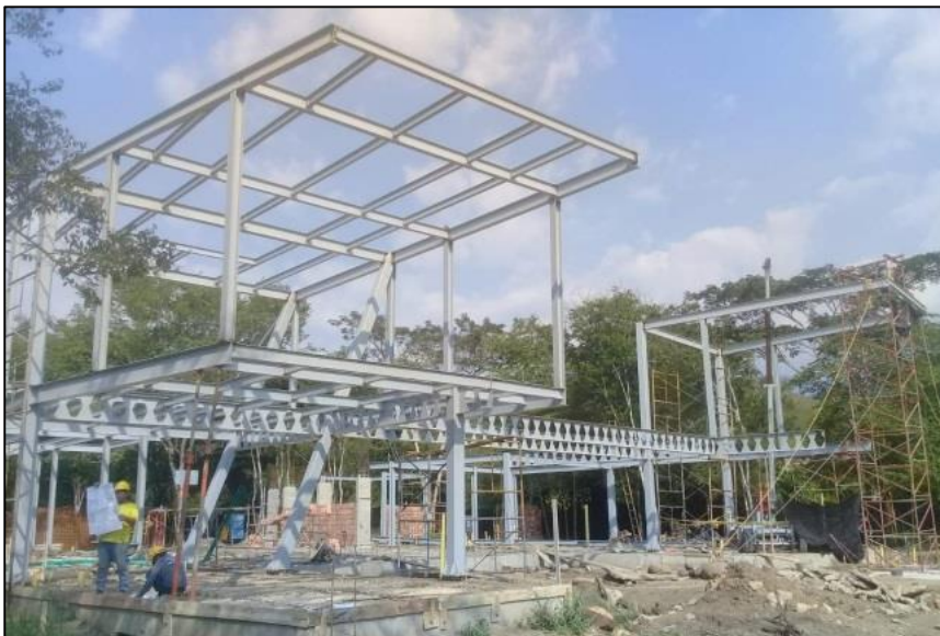
Figura 30. Avance de la construcción de la casa en Anapoima
