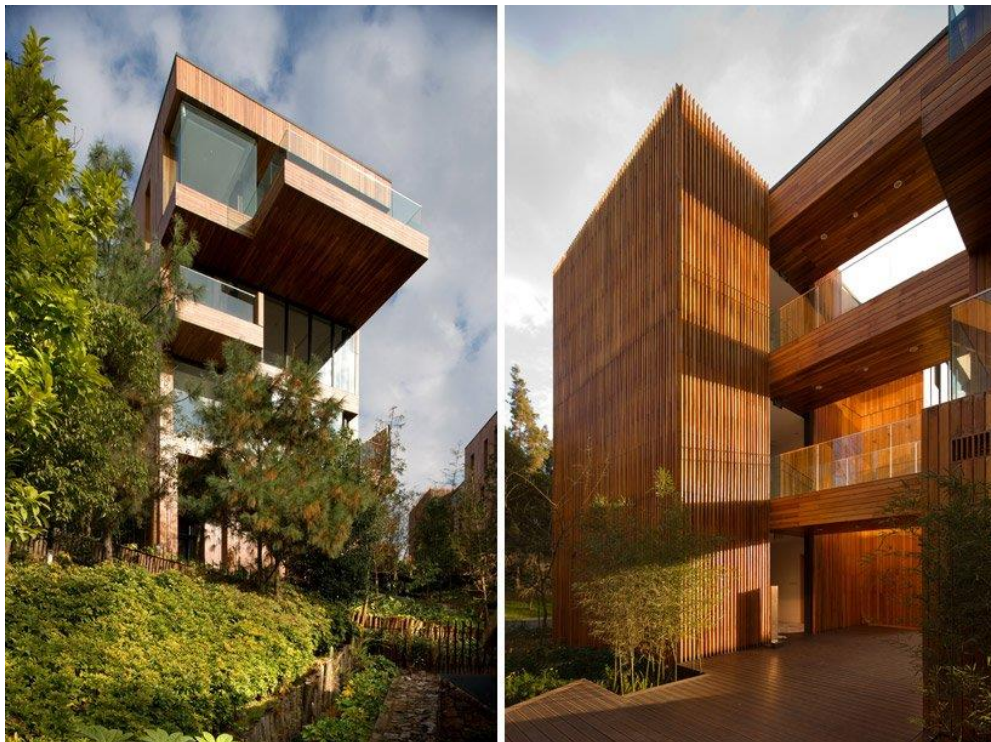
Figura 60. Voladizos y puentes 'hotel innhouse'
