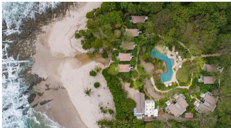
Figura 69. Vista panorámica de cubiertas
