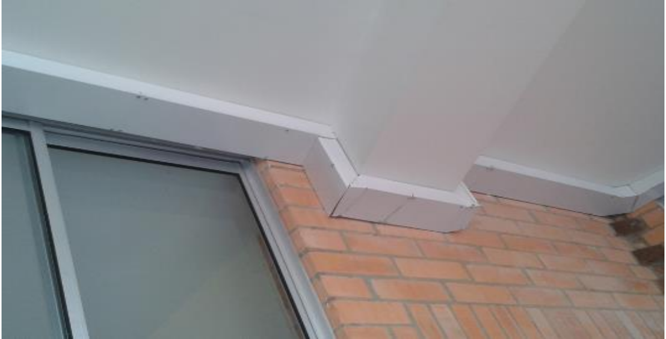
Anexo 7. Instalación de canaleta por todos los pisos del edificio.
