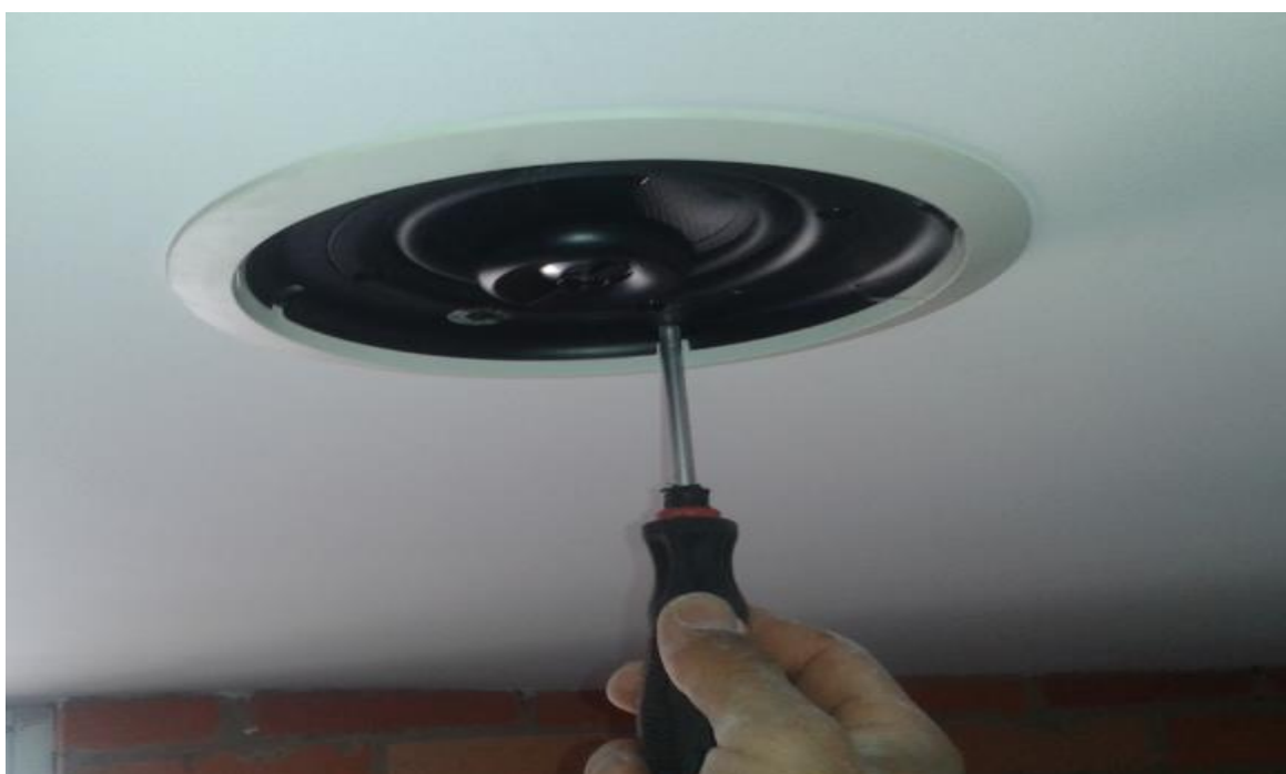
Anexo 13. Instalación completa del bafle.
