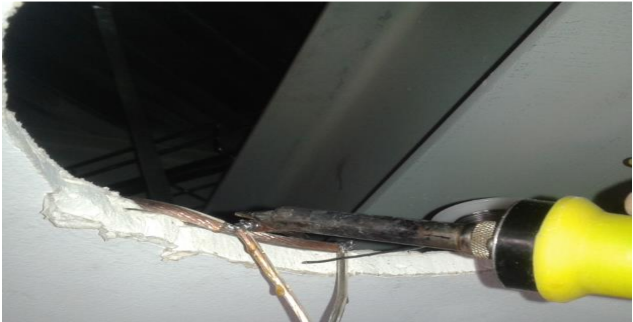
Anexo 8. Empalme en paralelo de los cables.
