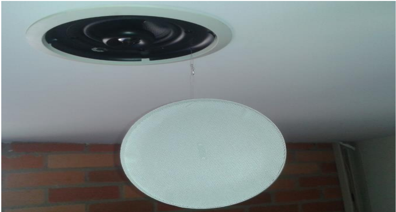
Anexo 15. Configuración del bafle a 70v-30w.
