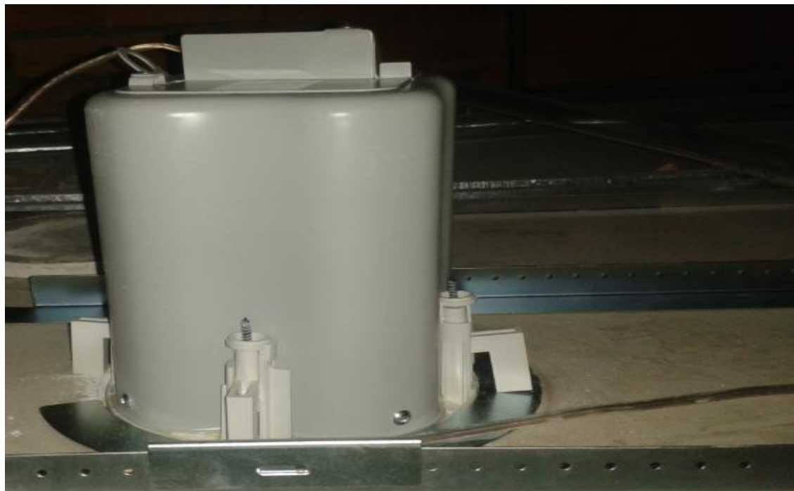
Anexo 13. Instalación completa del bafle.
