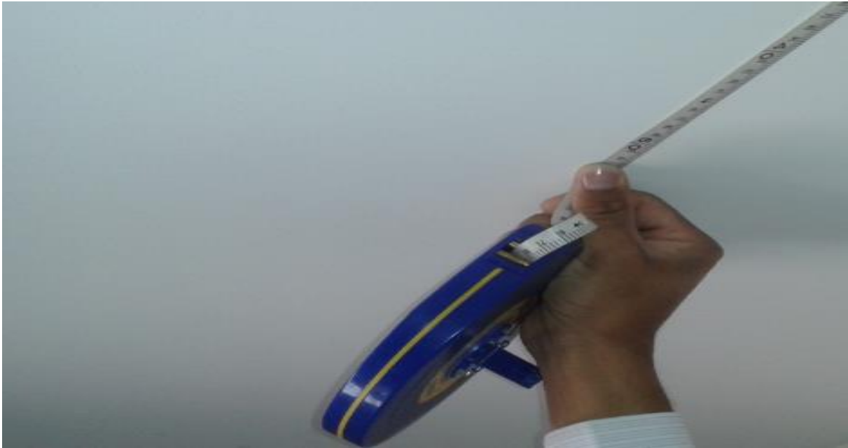
Anexo 4. Marcación para poder realizar el corte en el draibol.
