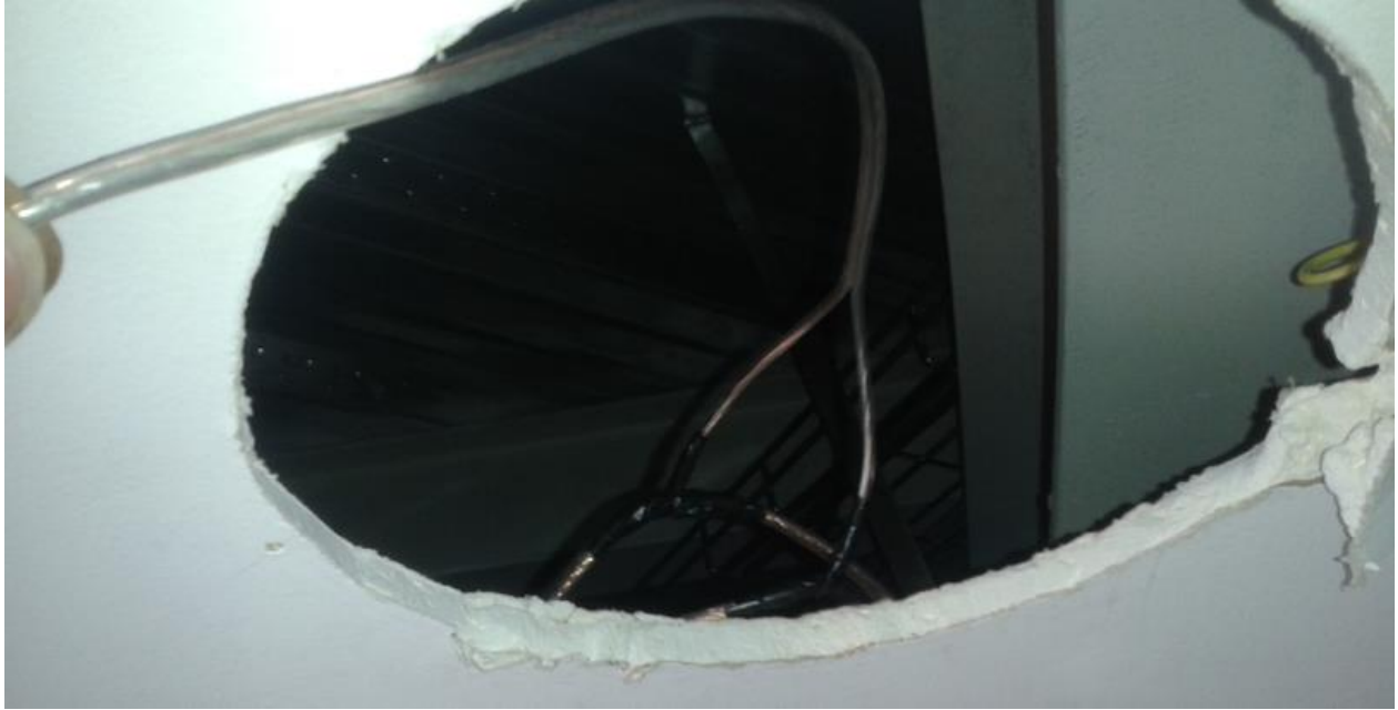
Anexo 9. Recubrimiento del empalme con cinta aislante.
