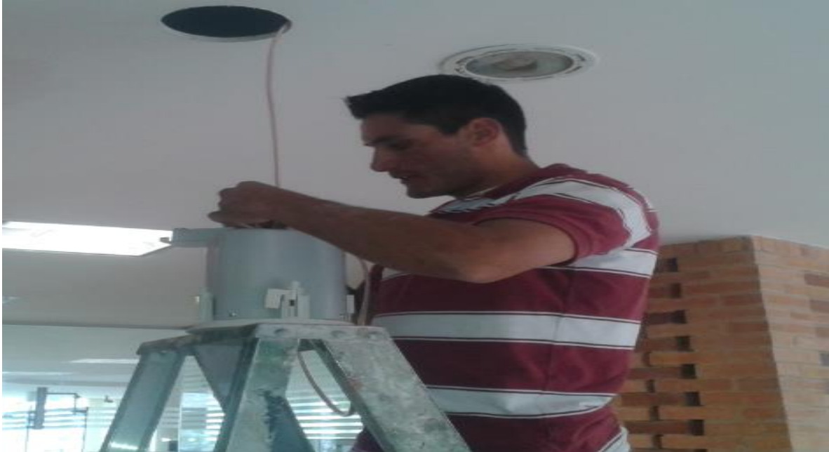
Anexo 11. Conexión del baffle.
