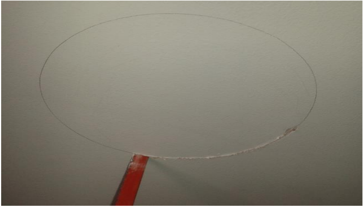
Anexo 6. Abertura del hueco en el draibol.
