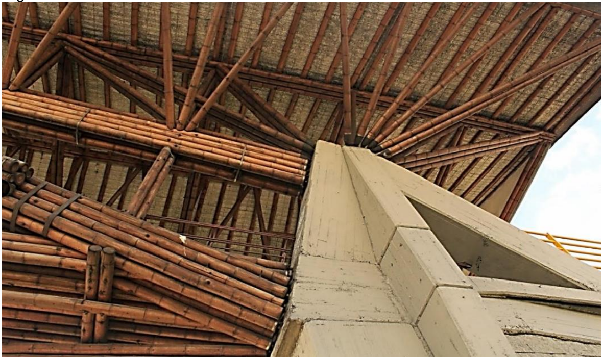
Figura 29. Costado oriental toma 3
