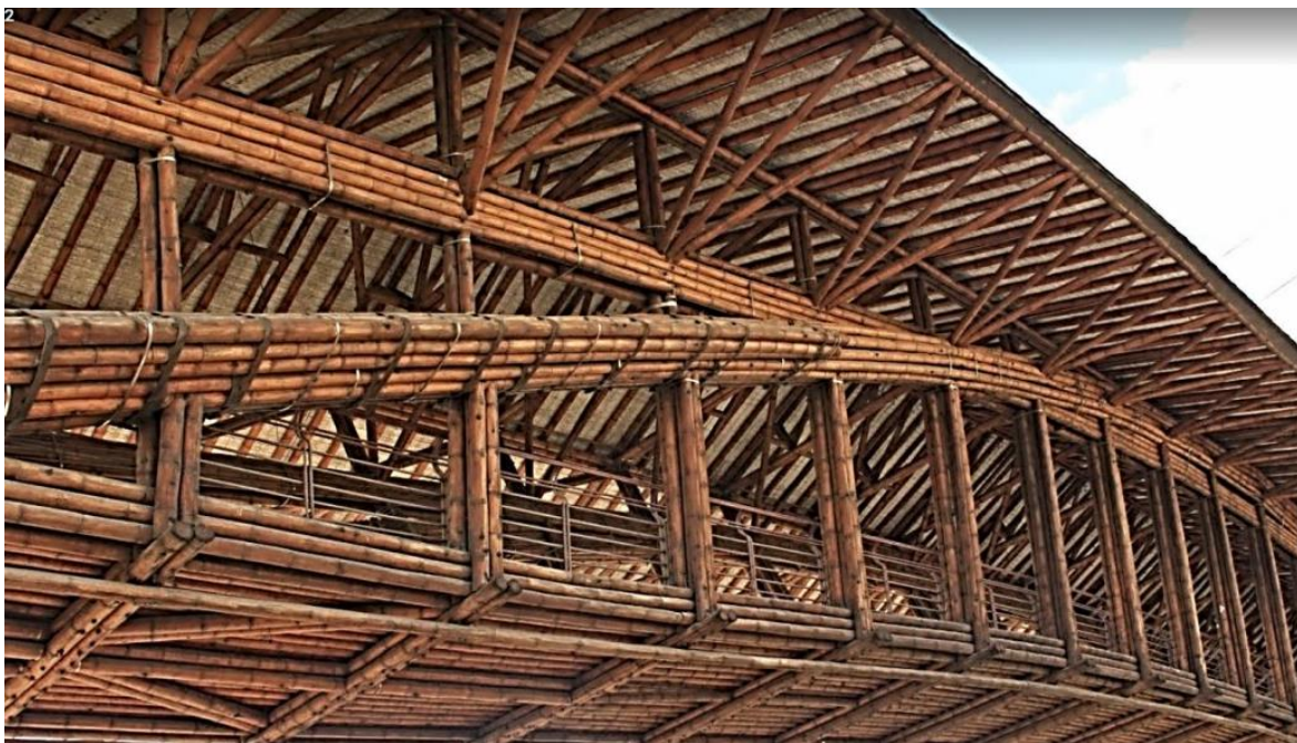
Figura 27. Costado oriental. Toma 1.
