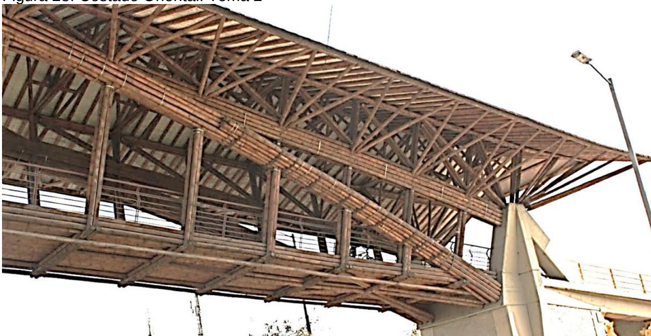
Figura 28. Costado Oriental. Toma 2
