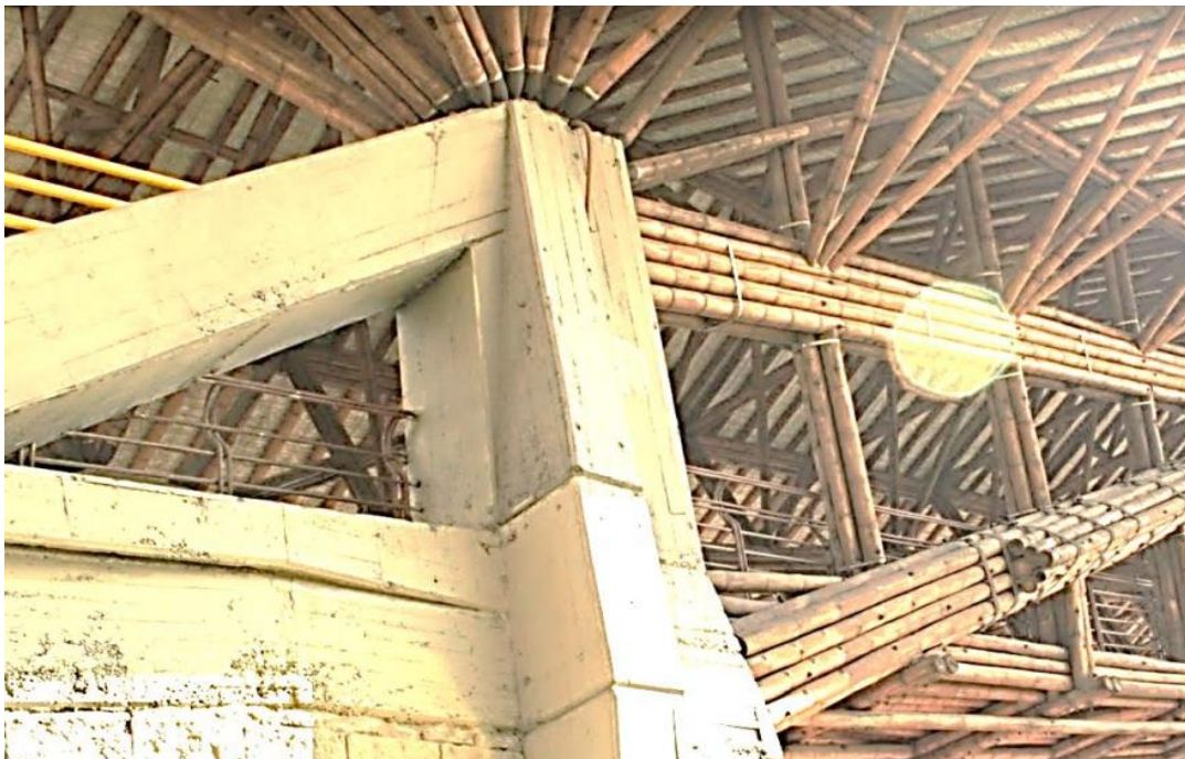
Figura 31. Estribo Occidental Norte
