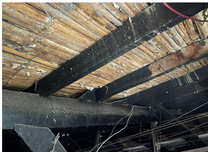
Ilustración 10 foto estructura de madera, fuente propia, 2022.
