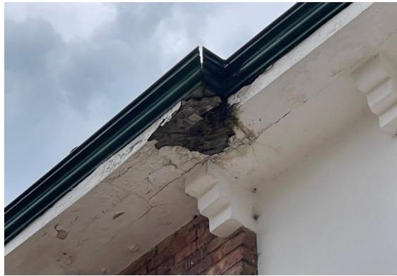
Ilustración 6 foto lesión humedad, fuente propia, 2022.
