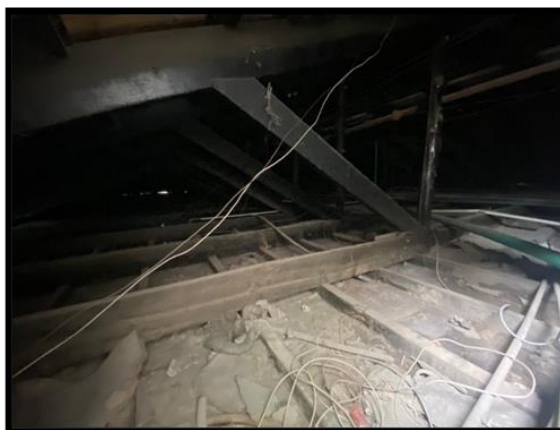
Ilustración 36 estructura de la cubierta
