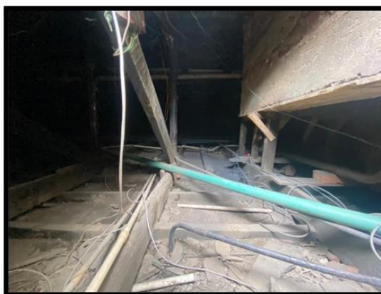
Ilustración 37 estructura de la cubierta
