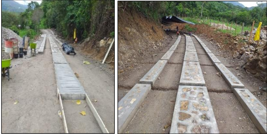
Imagen 9: Fundida del concreto ciclópeo con piedra pegada.
