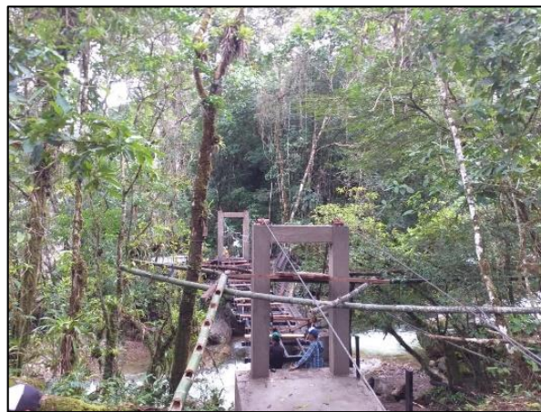
Imagen 27: Construcción de zapatas y torres para el puente peatonal.
