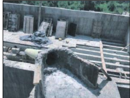
(b) Vaciado del concreto de 21 MPa
