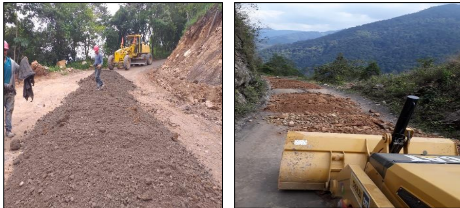
Imagen 5: Conformación de la subrasante y subbase granular desde el kilómetro 0.260 km hasta 0.798 km.
