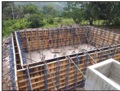
(a) Instalación de formaletas en madera
