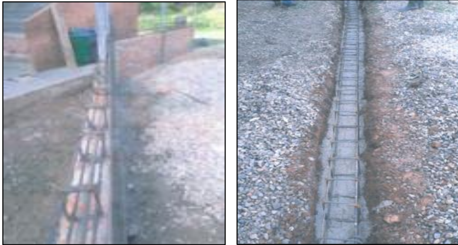
Imagen 30: Construcción de viga de amarre de 0.20m x 0.30 m
