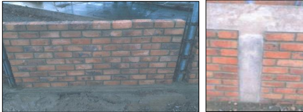
Imagen 31: Construcción de Columnetas de 0.25 m x 0.15 m.
