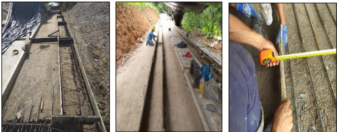
Imagen 8: Instalación de formaletas para concreto ciclópeo o piedra pegada.
