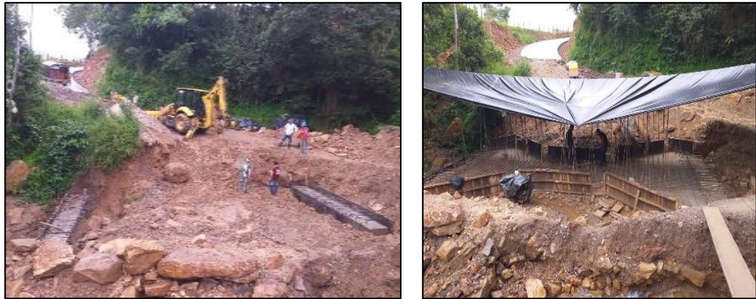
Imagen 13: Excavación mecánica para la construcción del Box culvert.
