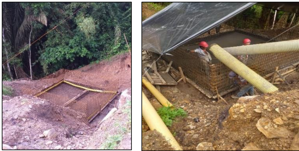
Imagen 24: Construcción del tanque para secado de lodos
