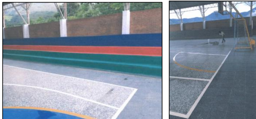
Imagen 33: Demarcación de la cancha.
