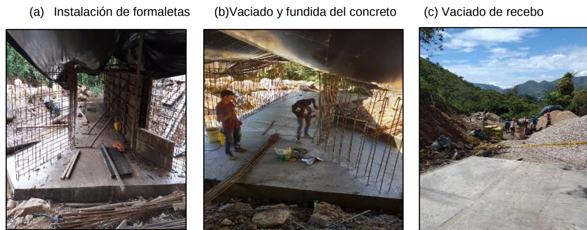
Imagen 15: Fundida de Box Culvert.
