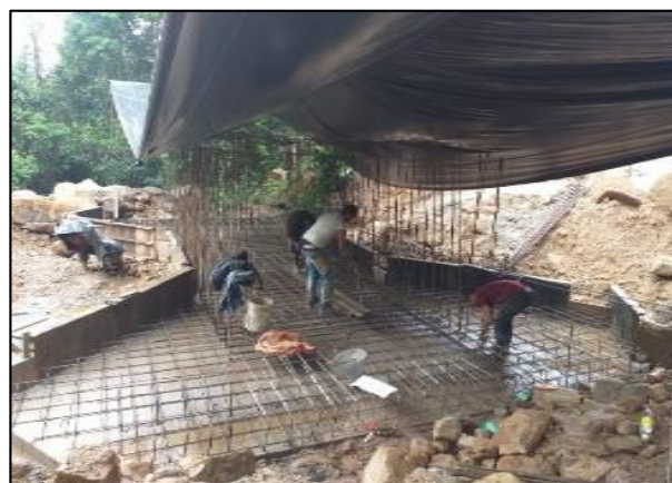
Imagen 14: Instalación de acero para Box Culvert
