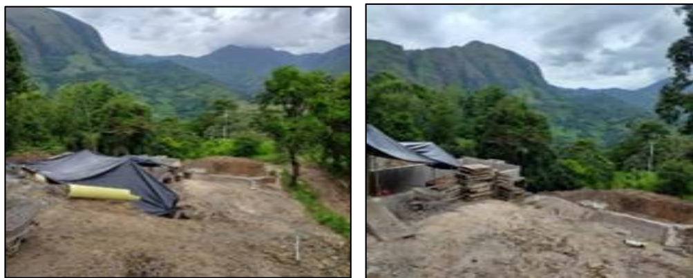
Imagen 16: Terreno para la construcción de la PTAR.
