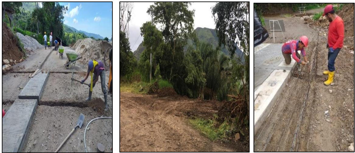
Imagen 11: Excavación manual de elementos estructurales de la placa huella.
