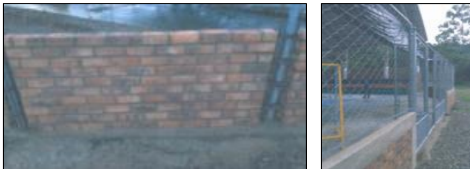
Imagen 32: Culminación del cerramiento del polideportivo.
