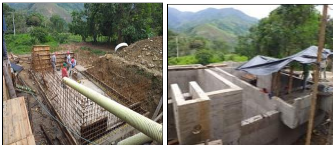
Imagen 19: Construcción del tanque sedimentador.
