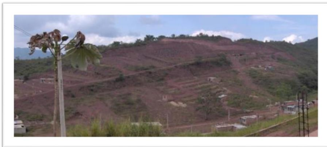
Figura 35. Cortes y perfilado del terreno sobre la parte occidental del predio
