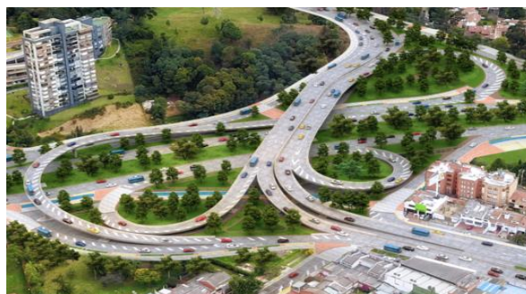
Figura 1. Vista General del Tramo Evaluado en el Puente Calle 127 con Av. Boyacá.
