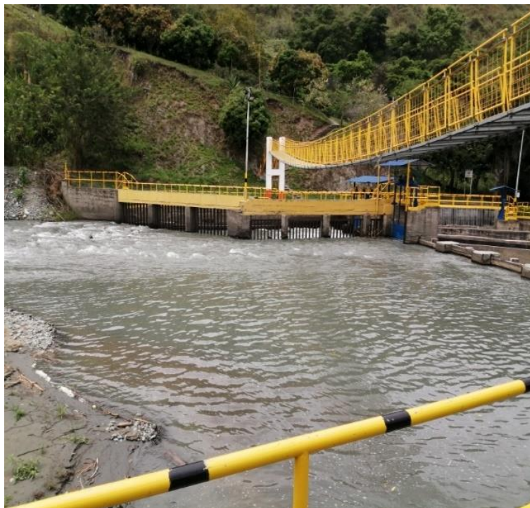
Fotografía 1. Localización toma de muestras.
