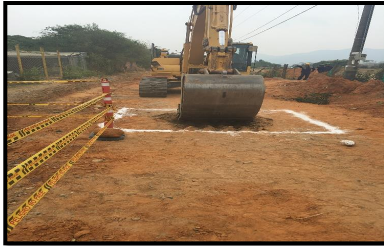
Fotografía 26. Excavación mecánica en conglomerado para pozos.
