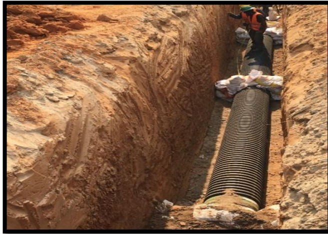
Fotografía 14. Instalación de tubería de 20"
