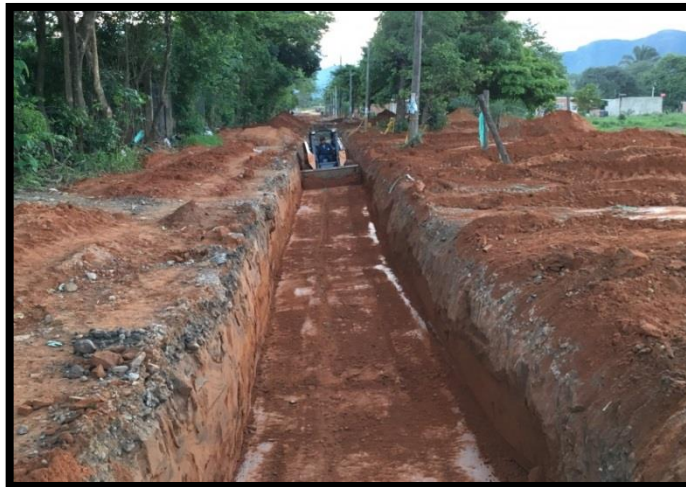
Fotografía 21. Esparcimiento del material de excavación.
