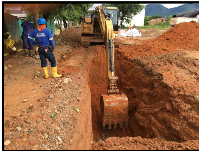
Fotografía 38. Excavación mecánica para la instalación de tubería.
