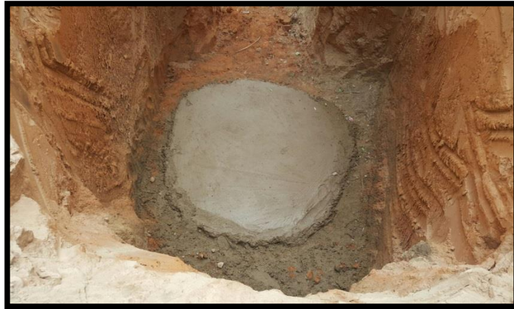
Fotografía 27. Solado para placa de piso en concreto de 2000 psi
