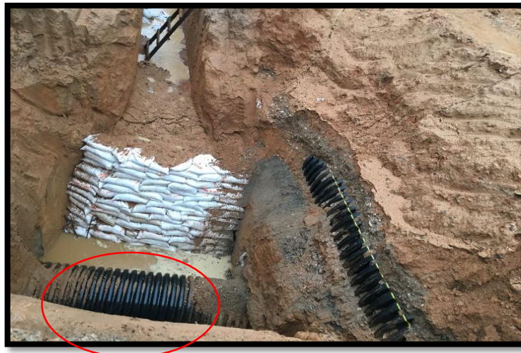
Fotografía 5. Localización red sanitaria existente a 6.00m de profundidad.
