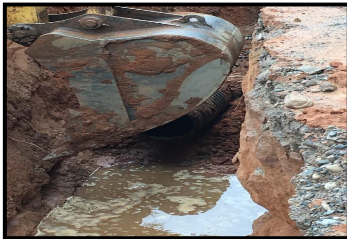
Fotografía 15. Limpieza de tubería afectada por lluvia
