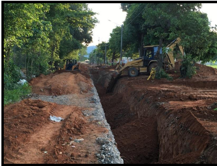
Fotografía 20. Relleno con material de excavación.
