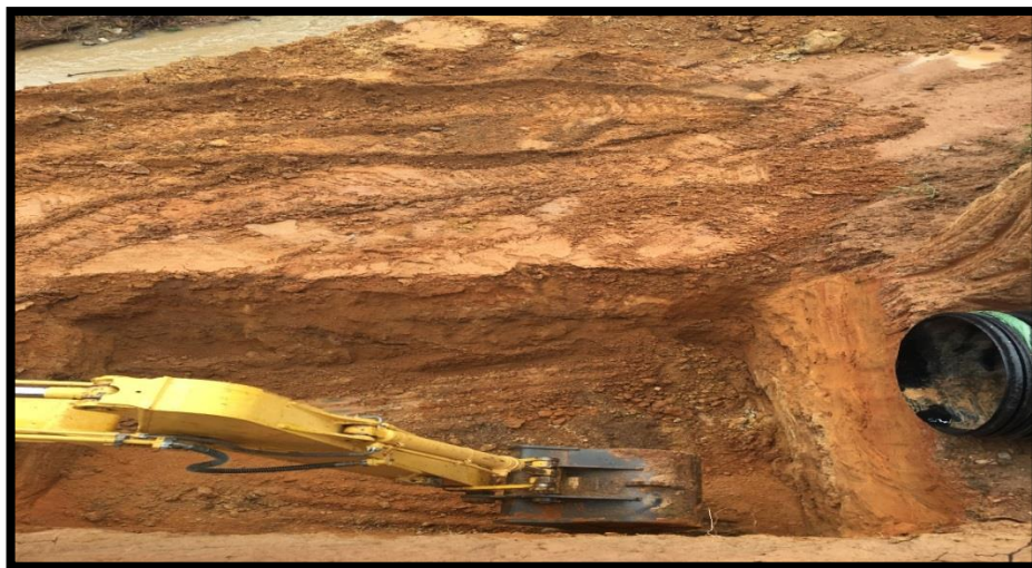
Fotografía 76. Excavación mecánica para la estructura de entrega.
