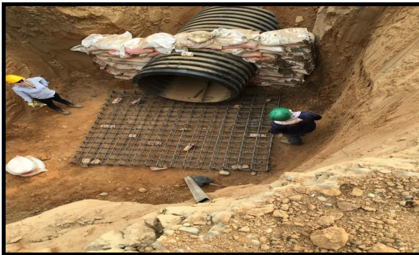
Fotografía 66. Instalación de parrilla de acero con varilla N°5.
