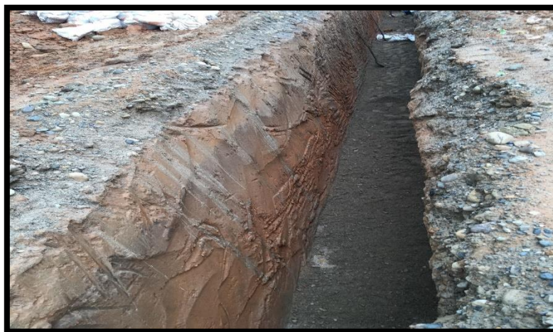
Fotografía 12. Encamado de arena de río sucia
