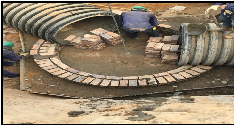
Fotografía 69. Construcción de pozos de inspección.
