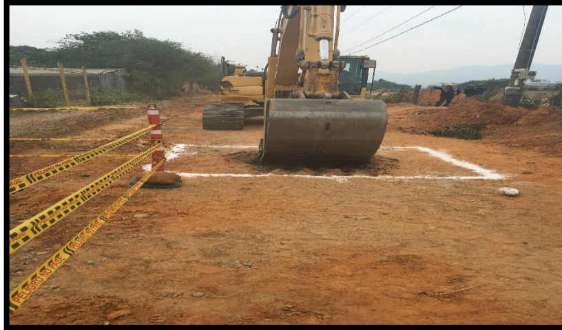
Fotografía 4. Localización y replanteo pozo 1 alcantarillado sanitario.
