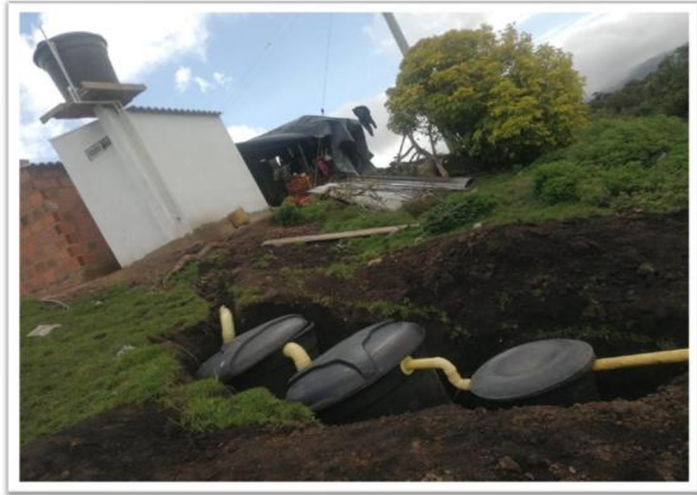
Ilustración 22. Instalación de Pozo séptico
