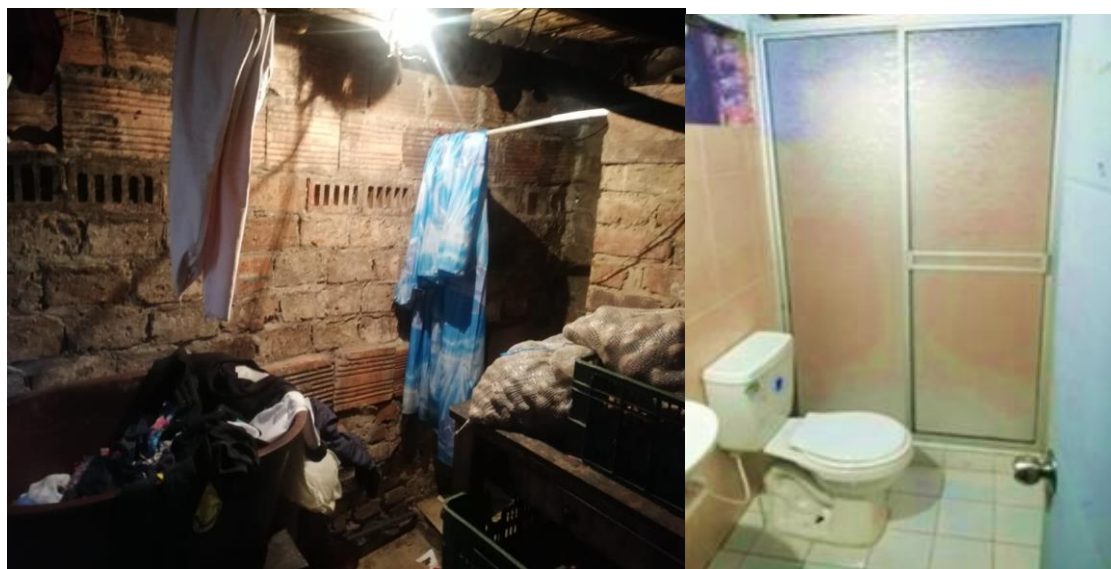
Ilustración 13. Mejoramiento de baño
