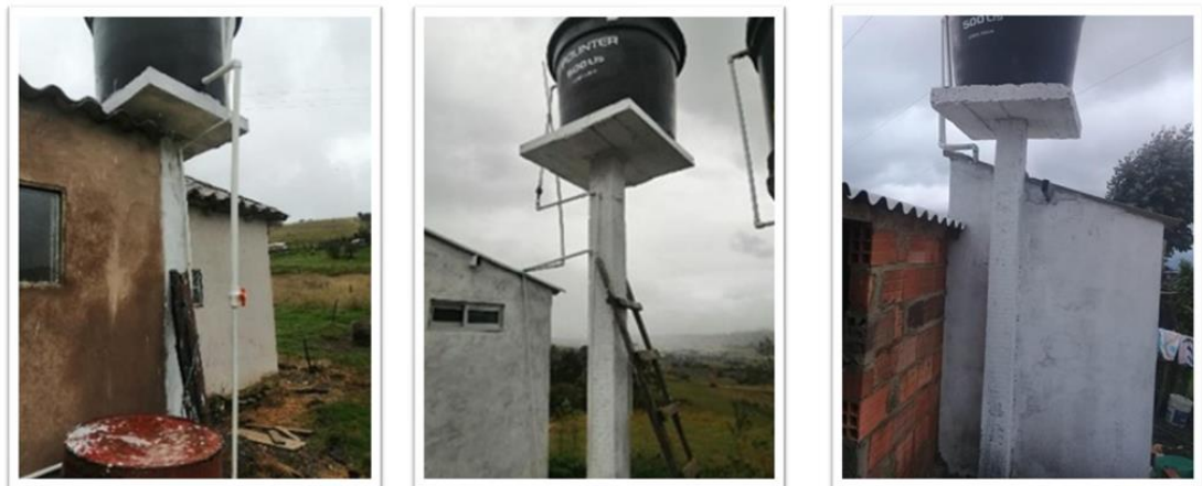
Ilustración 23. Instalación de Tanques elevados
