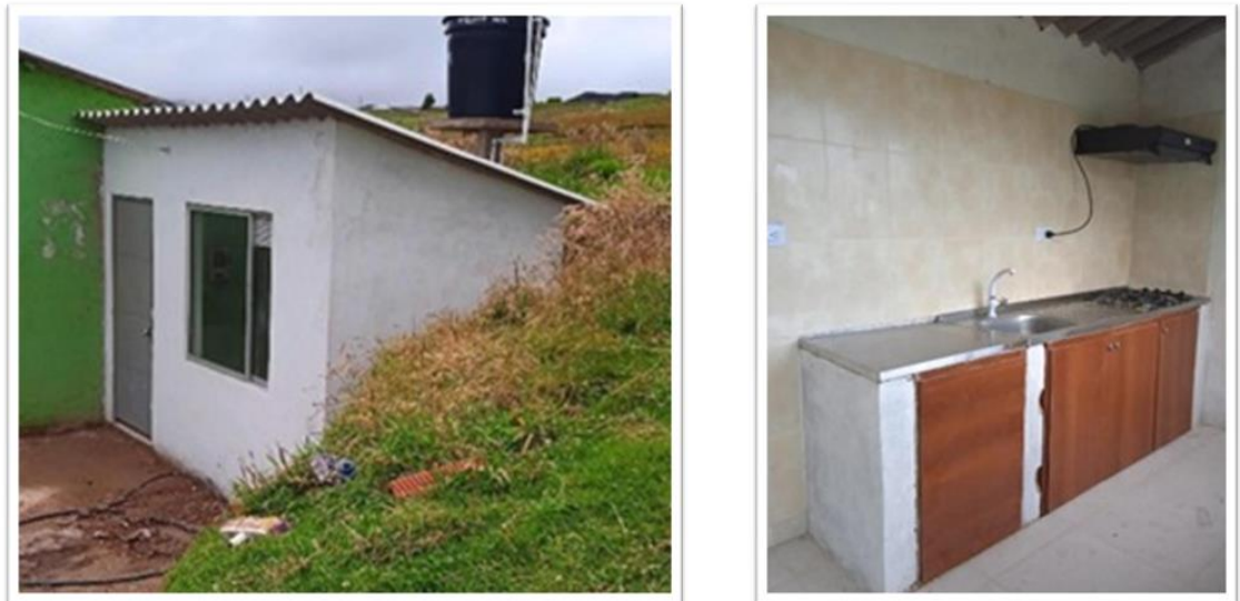
Ilustración 16. Construcción de cocina nueva
