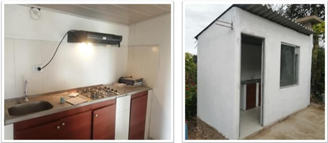
Ilustración 15. Construcción de cocina nueva
