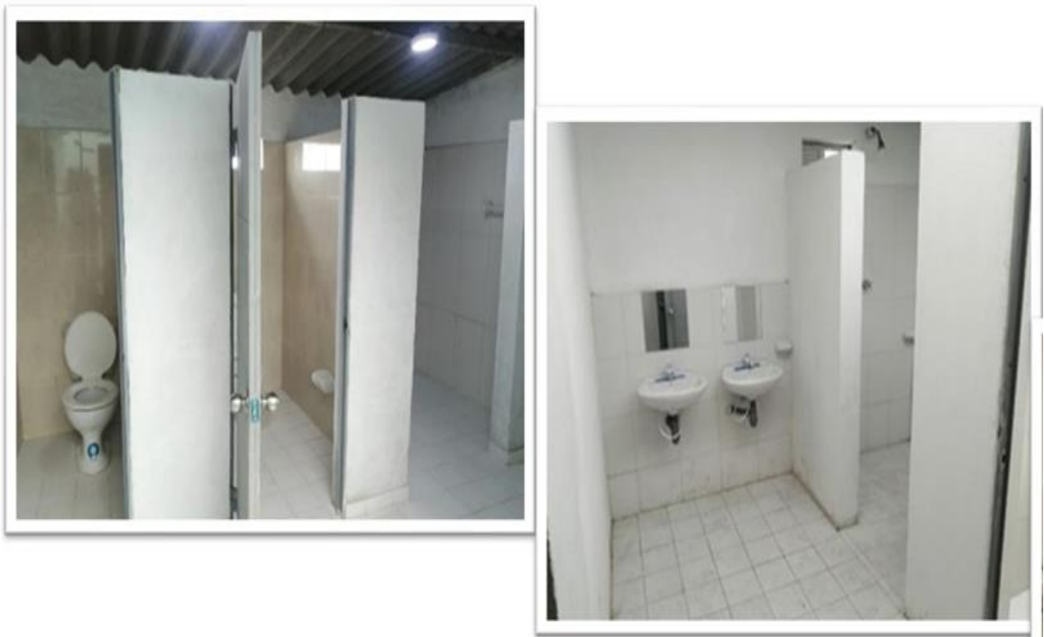
Ilustración 21. Mejoramiento baños ICBF
