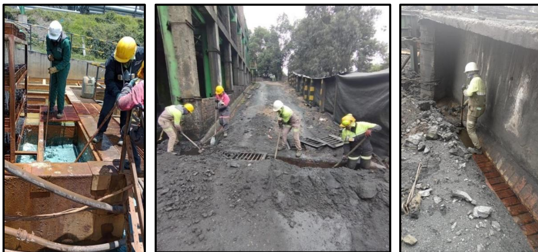
Ilustración 9. Mantenimiento de estructuras hídricas
