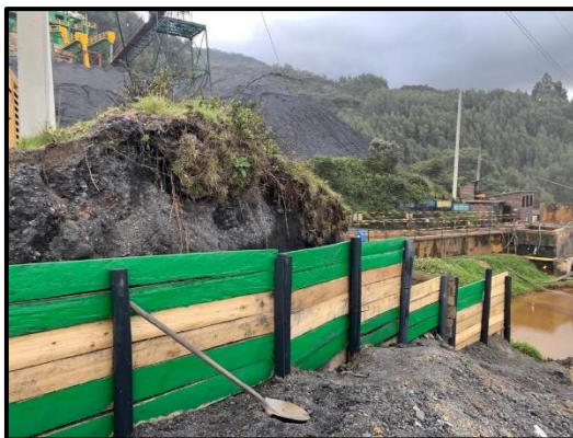
Ilustración 10. Muro de contención
