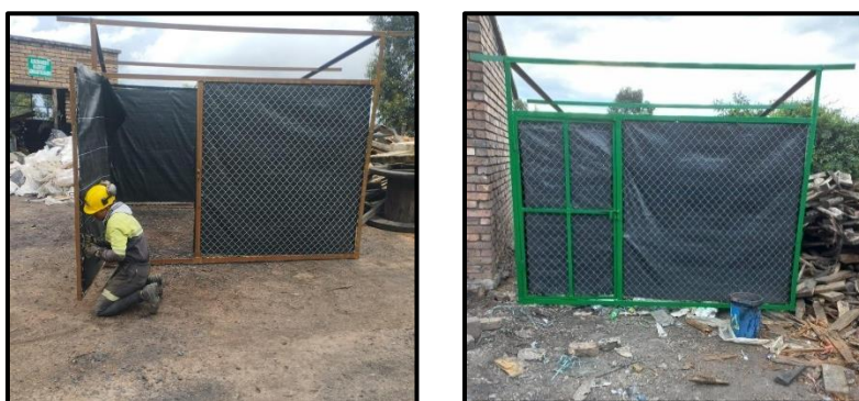
Ilustración 17. Depósito temporal de residuos sólidos
