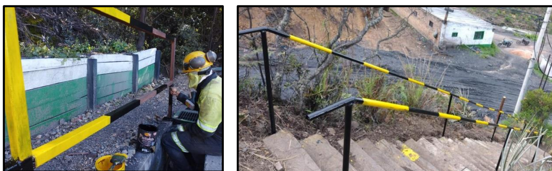
Ilustración 11. Mantenimiento de pintura
