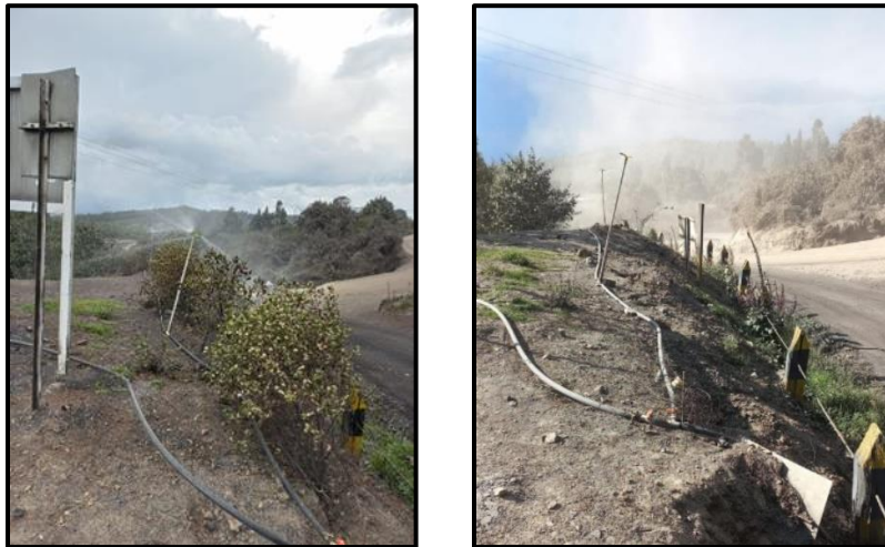
Ilustración 8. Sistema de humectación de vías
