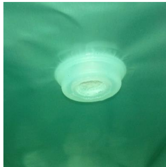
Figura 13. Válvula Desgasificadora - (Cara Interna)
