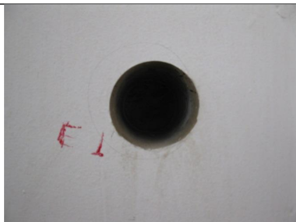
Foto 55 Extracción de Núcleos
