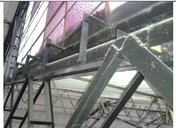
Foto 96 Colocación de contravientos
