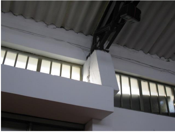
Foto 93 Apoyos de las cerchas
