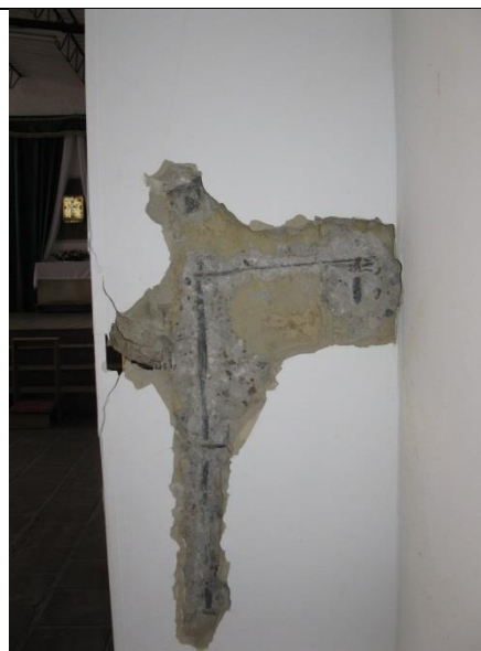
Foto 30 Verificación de acero
