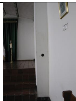
Foto 54 Extracción de Núcleos
