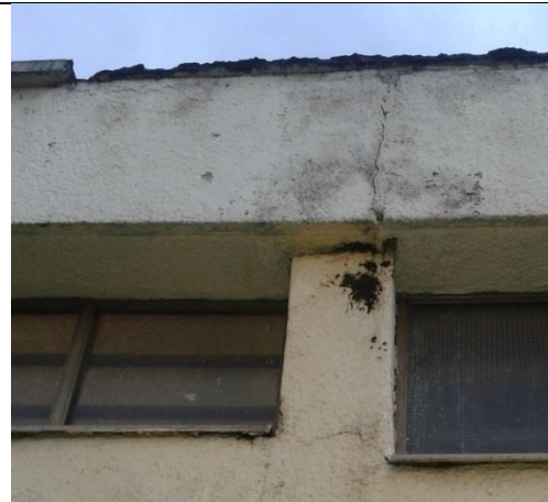
Foto 88 Efecto de columna corta
