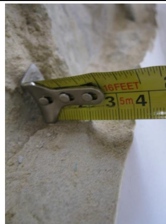
Foto 28 Recubrimiento de pañete lateral
