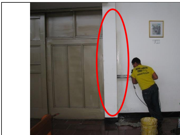
Foto 59 Extracción de núcleos de concreto columna
