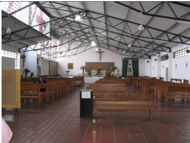
Foto 9 Humedad y temperatura en el ambiente Fuente: Ing. Sandra Cubides Febrero 2014
