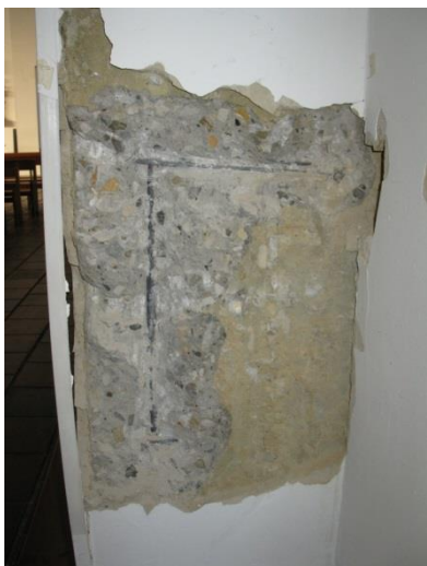
Foto 27 Recubrimiento entre concreto y pañete hasta el acero parte frontal
