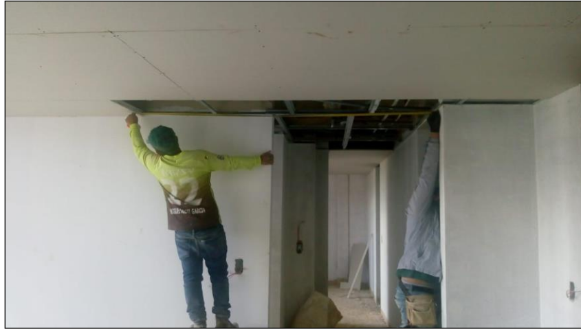
Figura 5. Instalación laminas de Drywall en apartamento 705.
