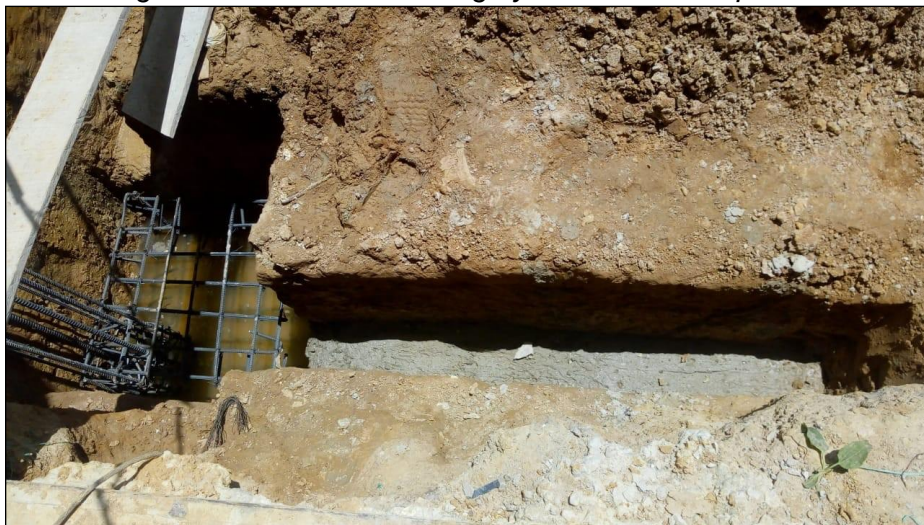
Figura 14. Excavación de viga y solado entre zapatas.
