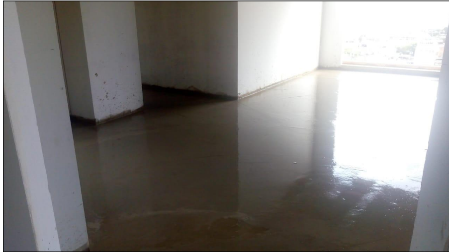
Figura 17. Fundido de contrapiso en apartamento 1003.
