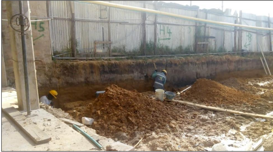
Figura 13. Excavación de tierra en ejes H-4, H-4 y H-3 para zapatas.
