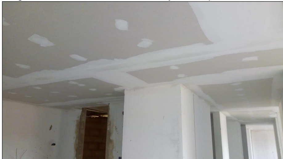
Figura 6. Enmasillado de láminas de Drywall en apartamento 203.
