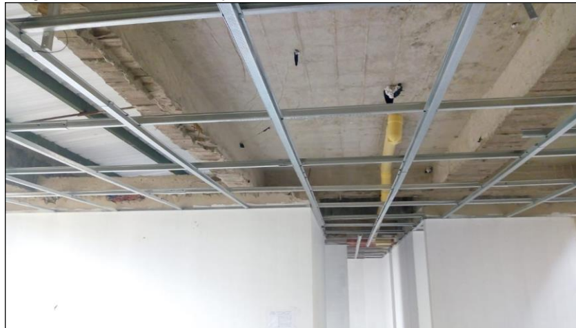
Figura 4. Perfiles de Drywall instalados en apartamento 1002.
