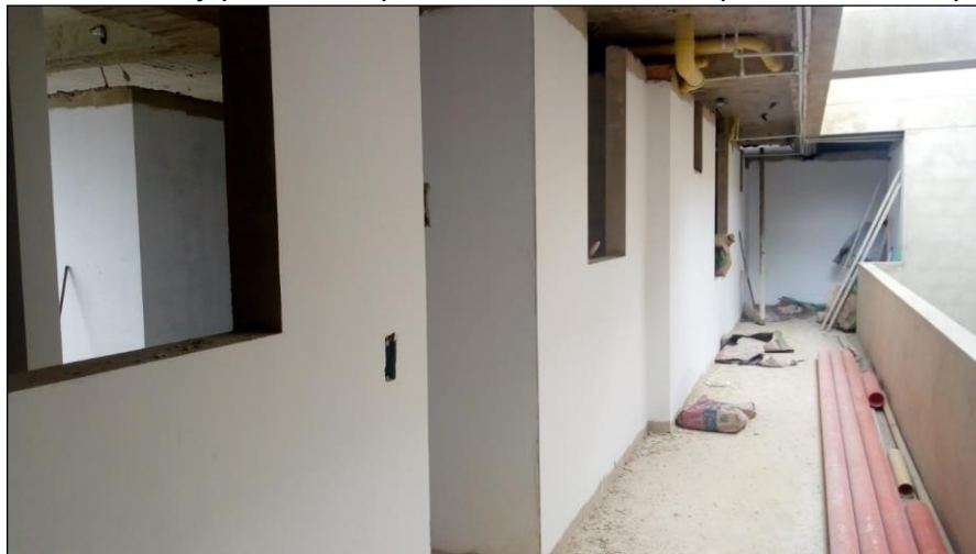
Figura 9. Estucado y pintado de paredes exteriores en apartamentos de piso 10.
