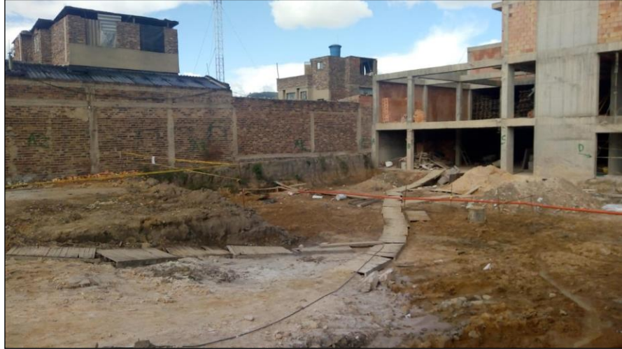
Figura 12. Determinación de ejes e inicio de cimentación en torre 1.
