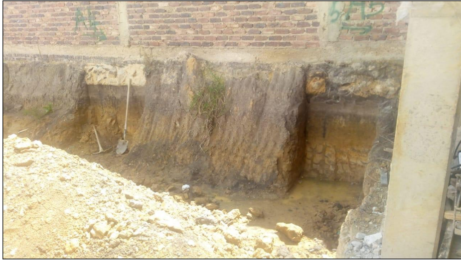
Figura 15. Excavación de zapatas en eje A.
