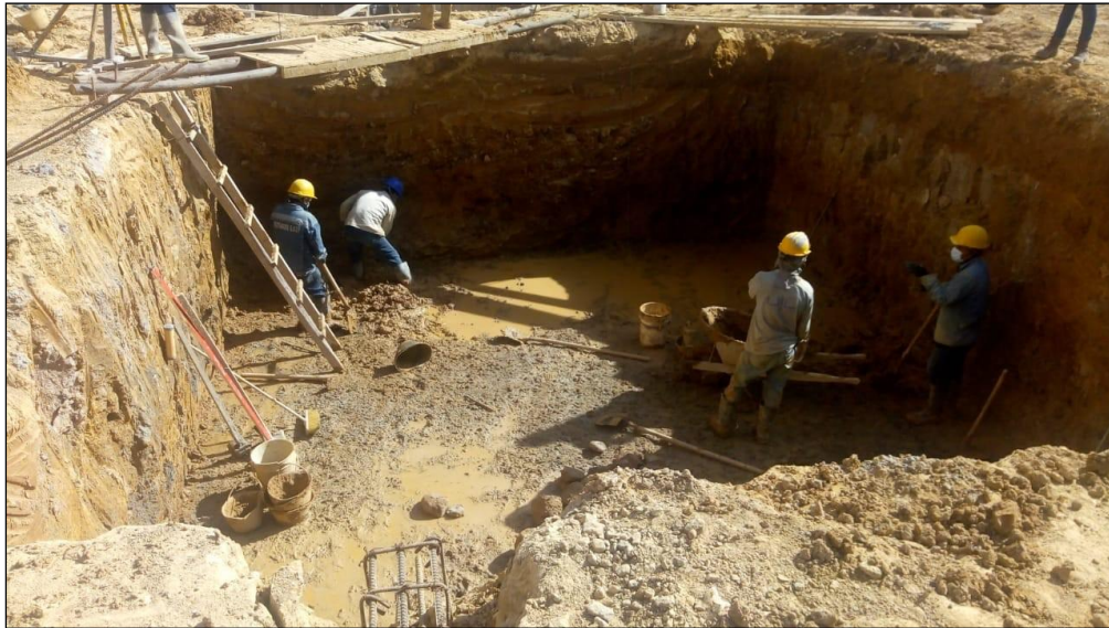
Figura 16. Excavación de la zapata N°15.
