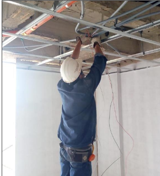
Figura 3. Instalación cableado eléctrico apartamento 606.
