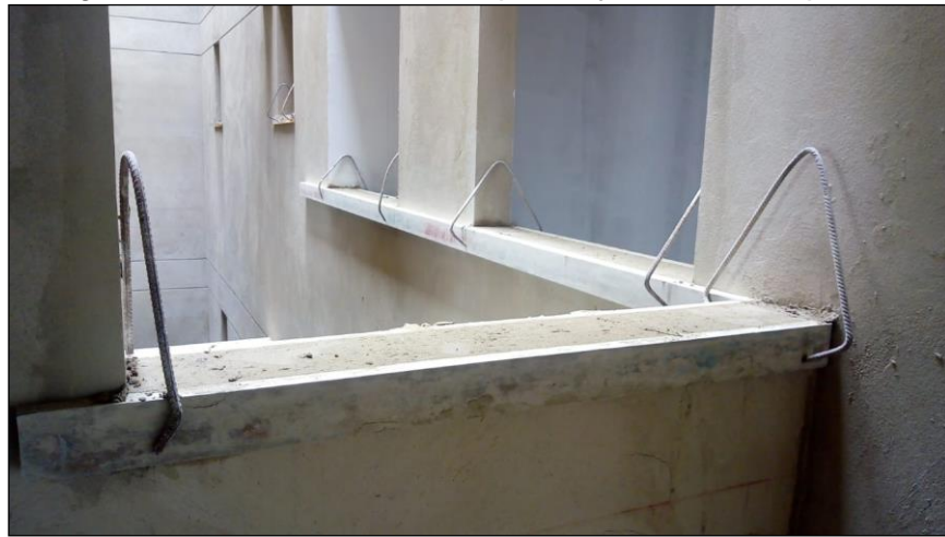
Figura 8. Afinado de bordes de pasillo y ventanas en piso 5.
