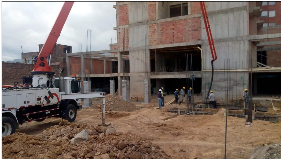
Figura 24. Fundido de concreto premezclado para la zapata N°26.
