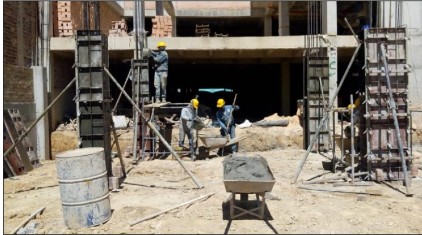
Figura 22. Fundido de concreto de las columnas de las zapatas N°11, 12, 16 y 17.
