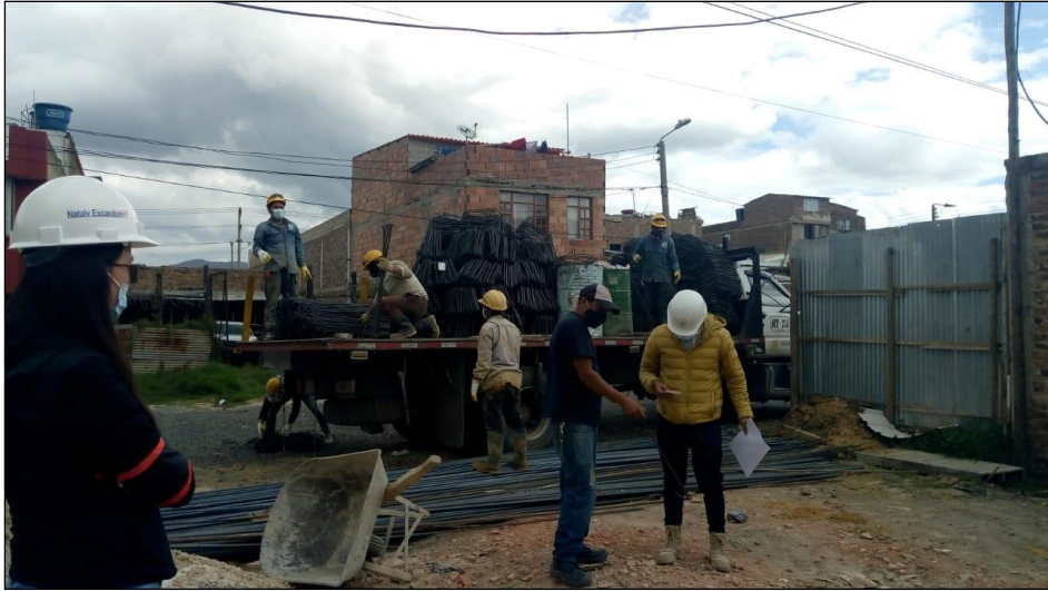
Figura 26. Recibimiento de acero en obra por parte de la empresa GYJ.
