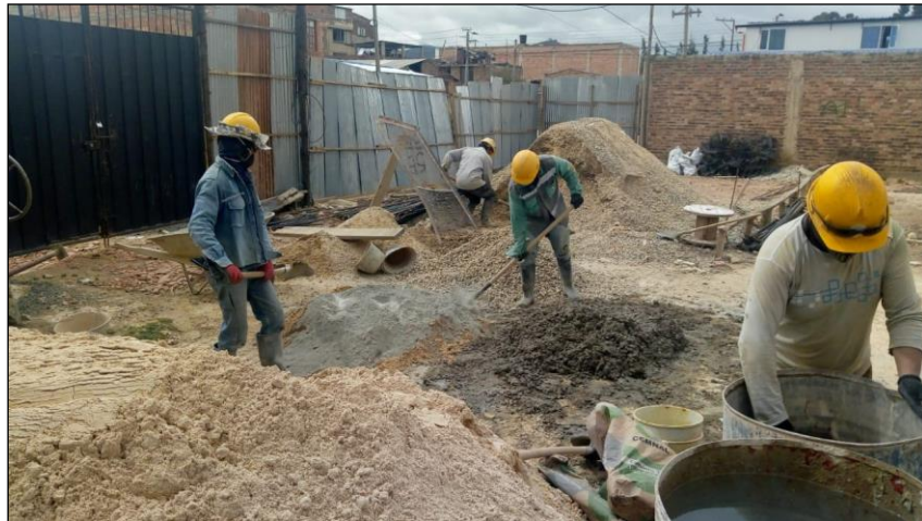
Figura 21. Mezcla de concreto en obra.
