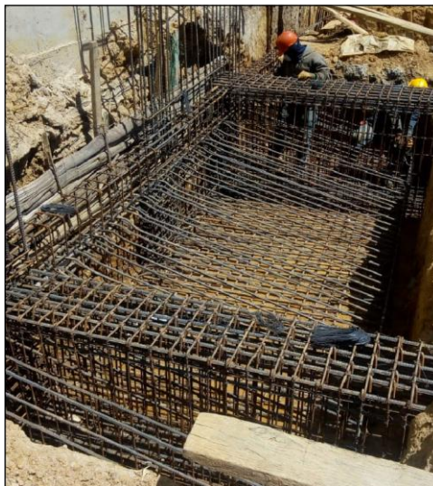
Figura 19. Acero de refuerzo colocado en la zapata N°26.
