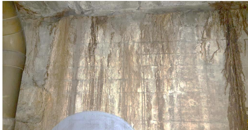
Fotografía N° 6. Lesiones presentadas en el sótano (tomada por Goyes-2017)
