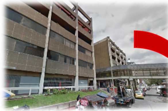
Fotografía N° 1. Vista general edificio calle 47 (goyes-2016)
