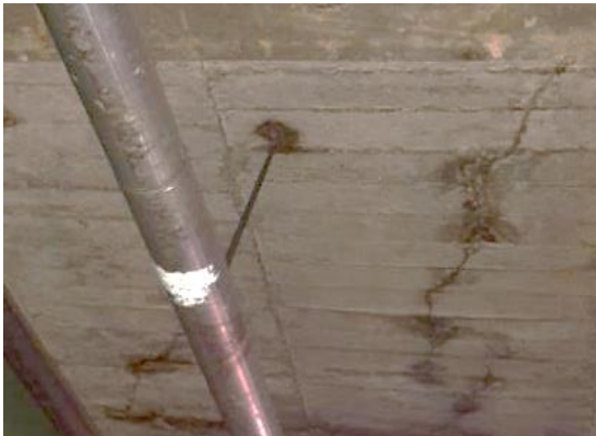
Fotografía N° 7 Lesiones químicas área sótano (tomada por Goyes-2017)
