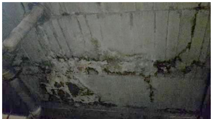
Fotografía N° 7 Lesiones químicas área sótano (tomada por Goyes-2017)
