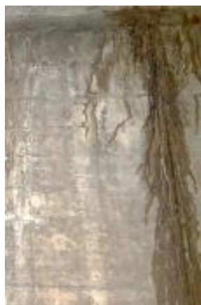
Fotografía N° 8. Lesiones químicas – sótano (tomada por Goyes-2017)
