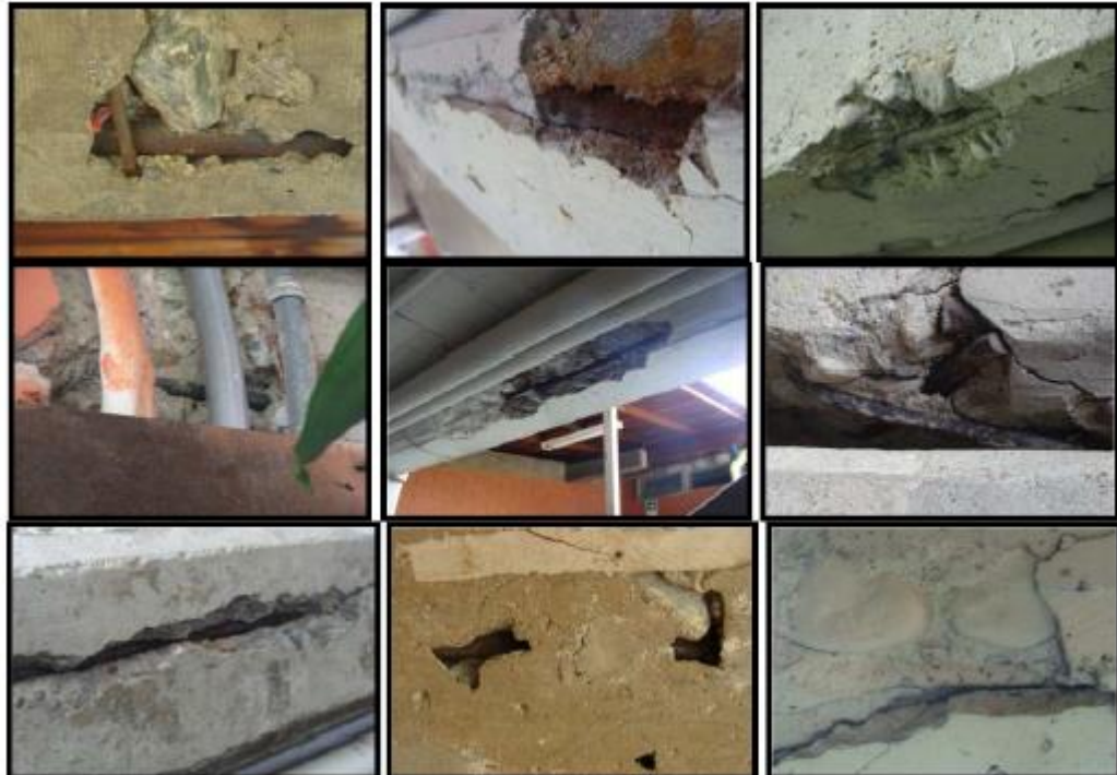
Foto 1. Inspección de refuerzo
