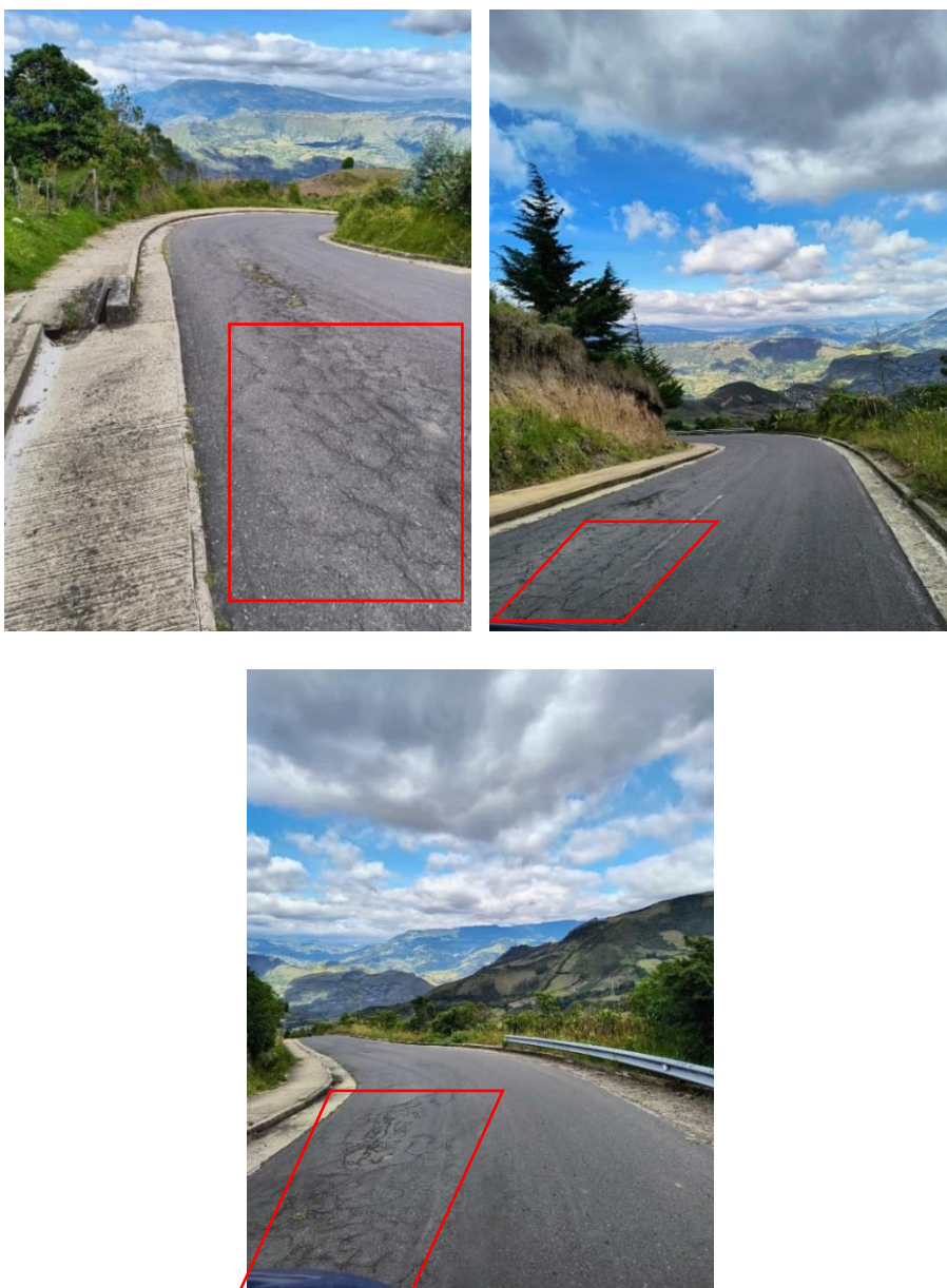
Ilustración 3, Piel de cocodrilo, fuente; elaboración Propia
