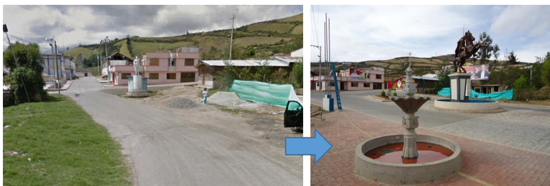
Ilustración 11, construcción glorieta entrada
