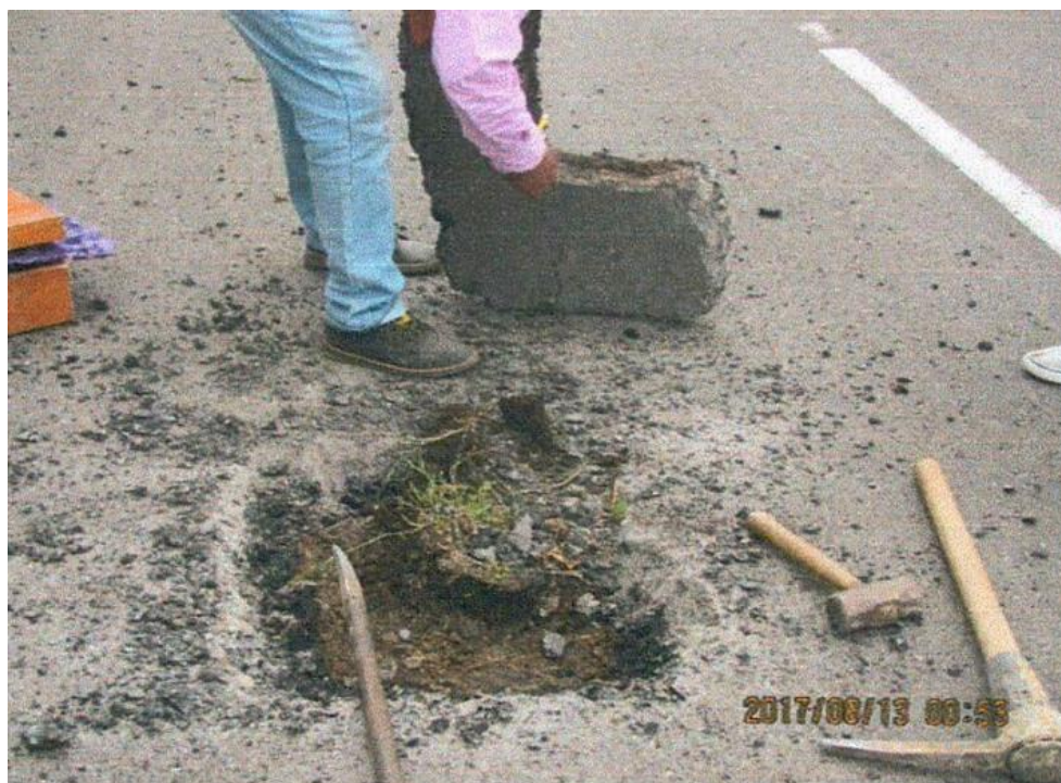
Ilustración 26, apique #3, fuente; peritaje y estudio de responsabilidad. Anexo 1
