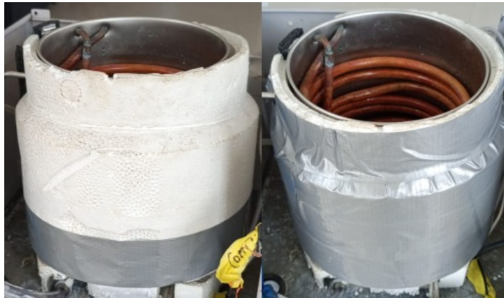
Figura 5.4.13: El antes y el después de aplicar recubrimiento en el tanque.
