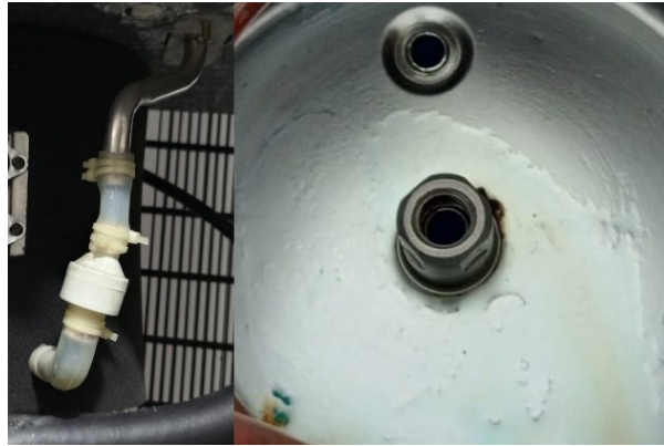
Figura 5.4.15: A la izquierda se ve la manguera que conecta la entrada de líquido de la resistencia con el recipiente, a la derecha se ve el drenaje por el cual el líquido es bombeado.
