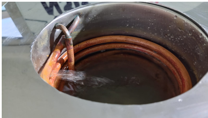
Figura 5.5.5: Líquido siendo retornado al recipiente mediante bombeo.
