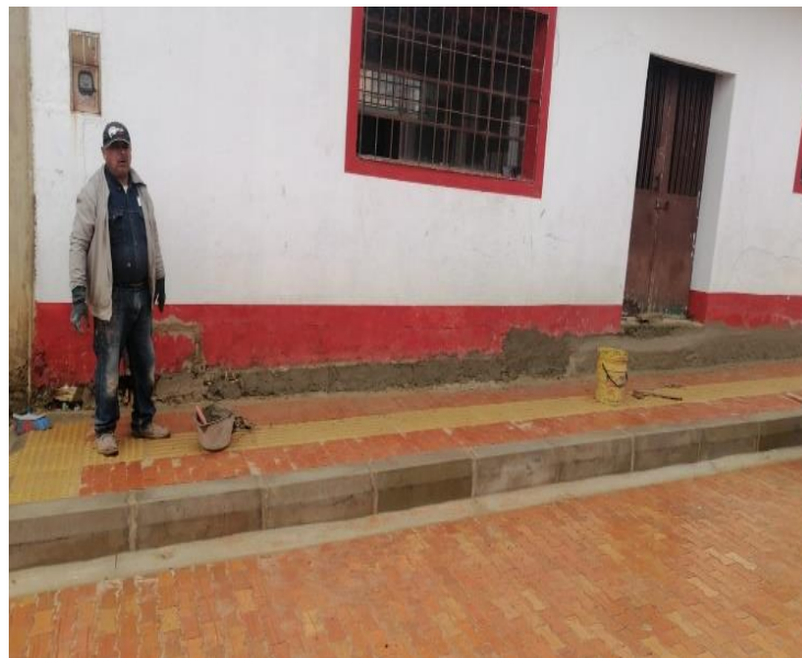
Instalación de adoquín
