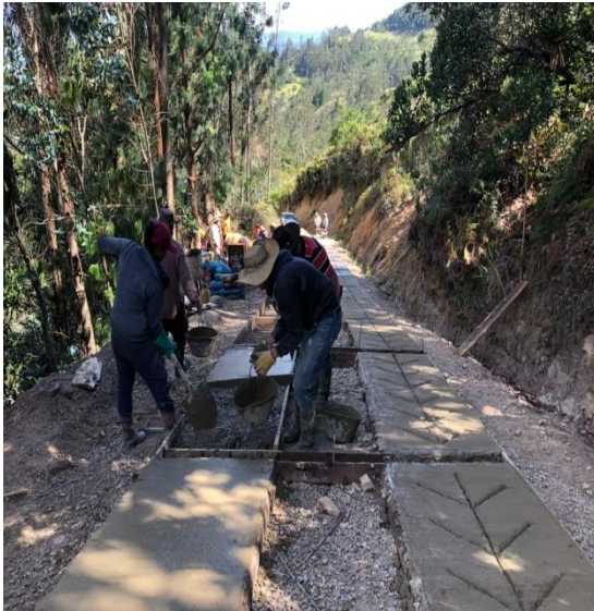
Figura 3 Vaciado del concreto clase G
