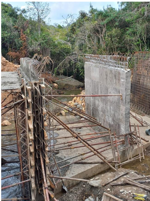
Fundición primer muro estructural
