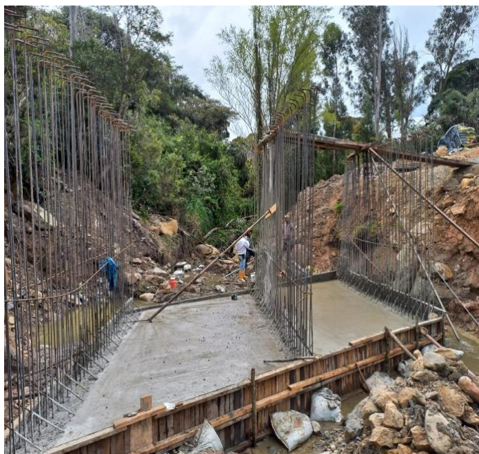
Fundición primer muro estructural
