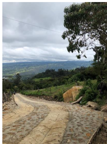
Figura 12 Segundo tramo de cinta huella Pantanillo
