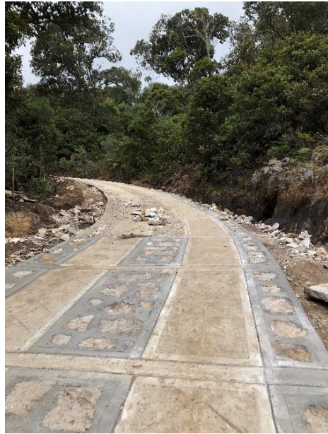
Figura 6 Colocación de la piedra pegada
