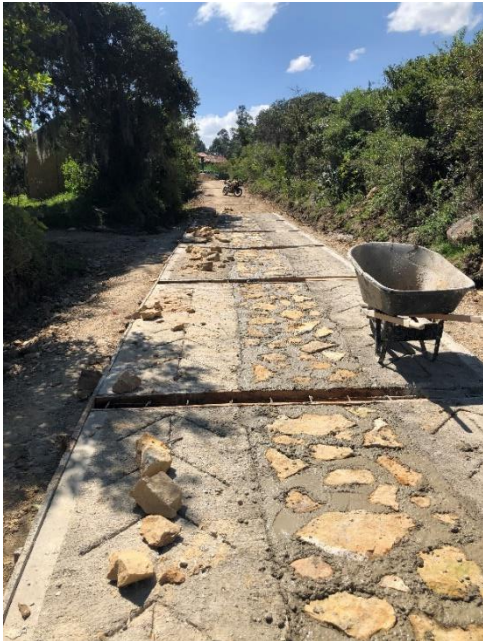
Figura 5 Fundición de concreto ciclópeo
