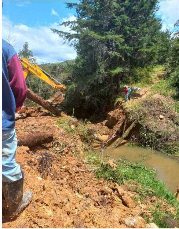
Demolición del puente existente
