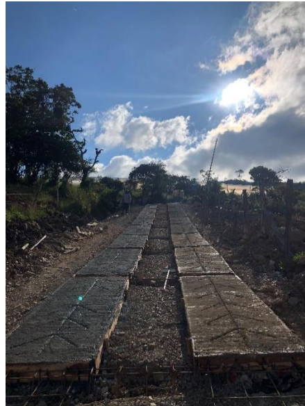
Figura 4 Conformación de la Vía
