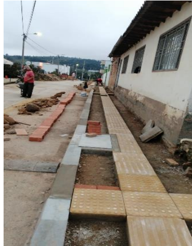
Instalación de Loseta
