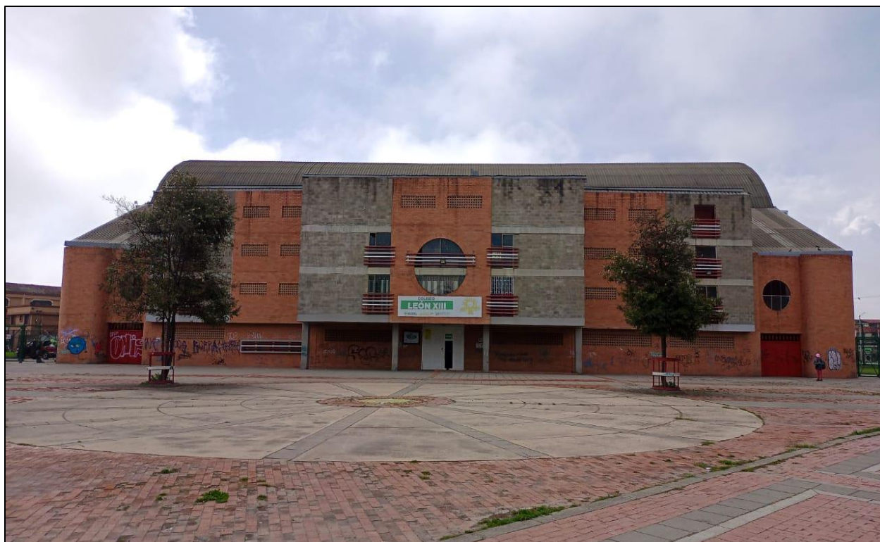
Ilustración 8 - Estado Actual Fachada Frontal.
