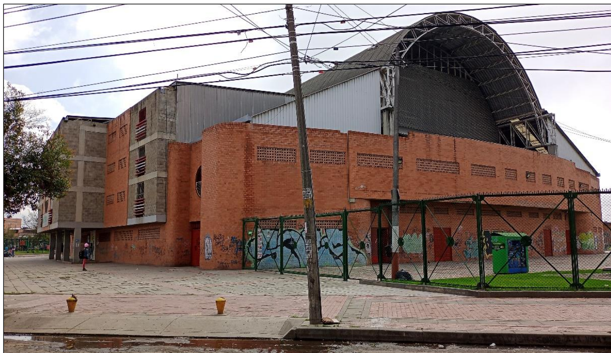
Ilustración 42 - Fachada lado Norte Coliseo León XIII
