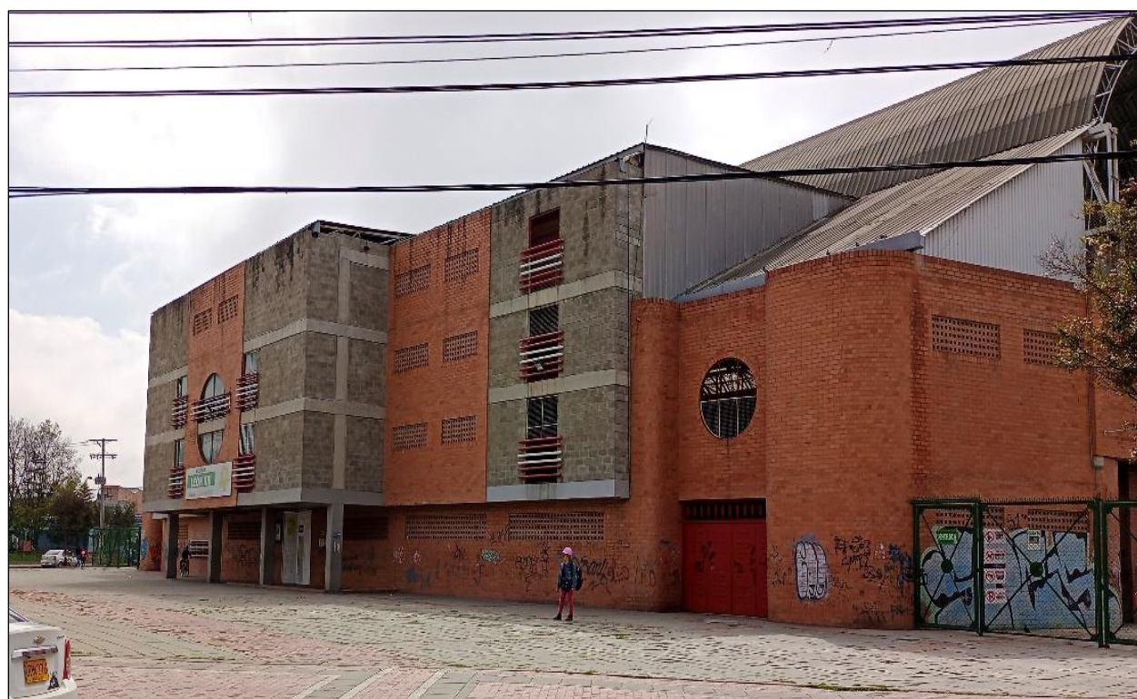
Ilustración 43 - Fachada lado Oriente Coliseo León XIII, entrada ppal.
