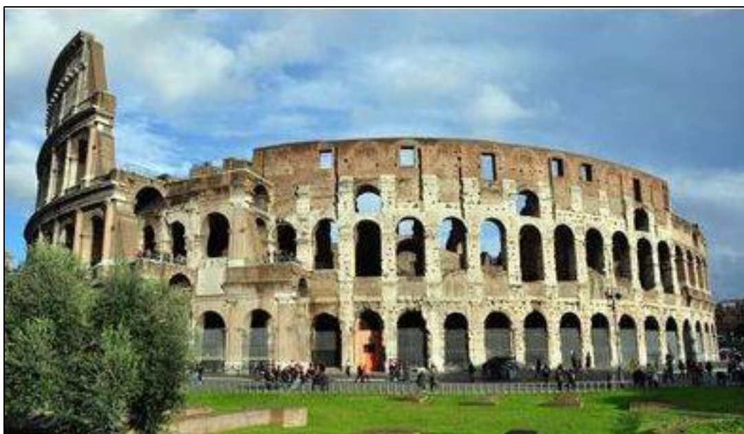
Ilustración 11 - Reparaciones Realizadas al Coliseo.
