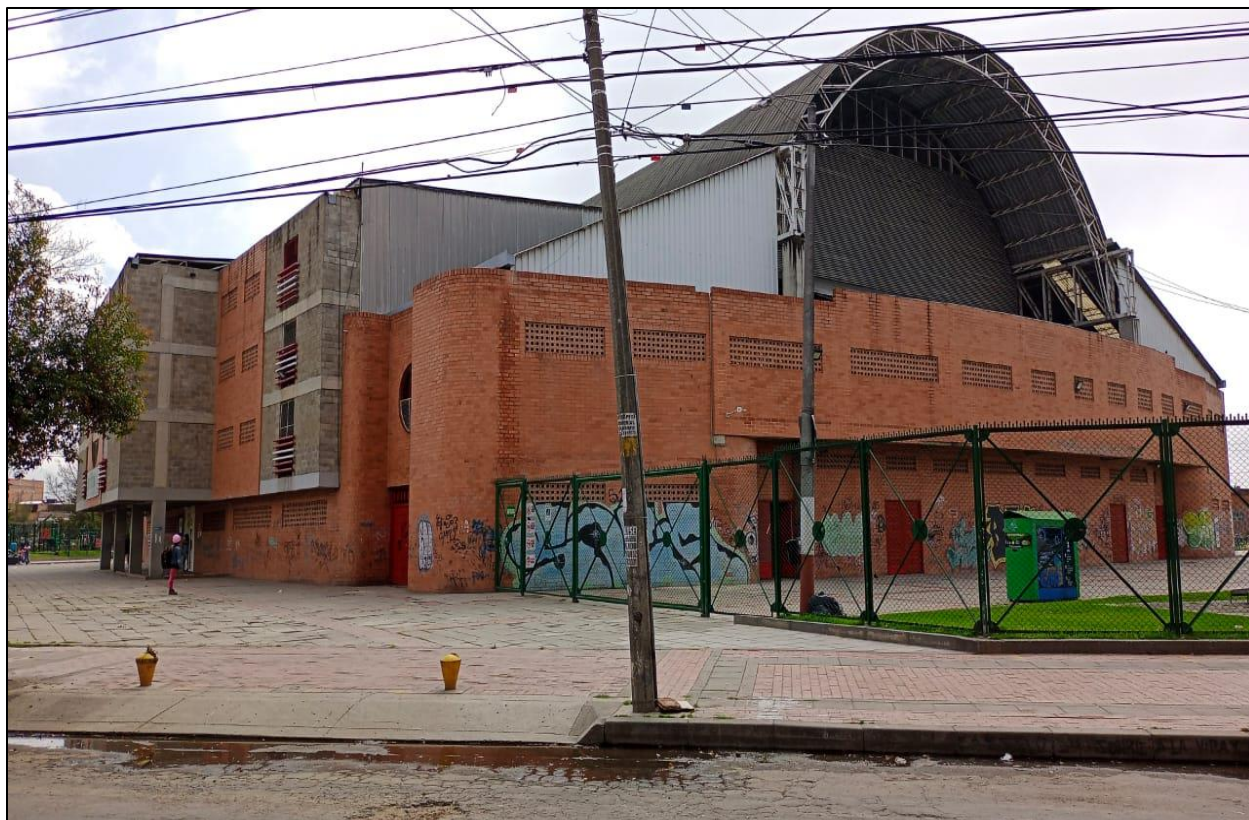
Ilustración 7 - Estado Actual Fachada Sur Occidental.
