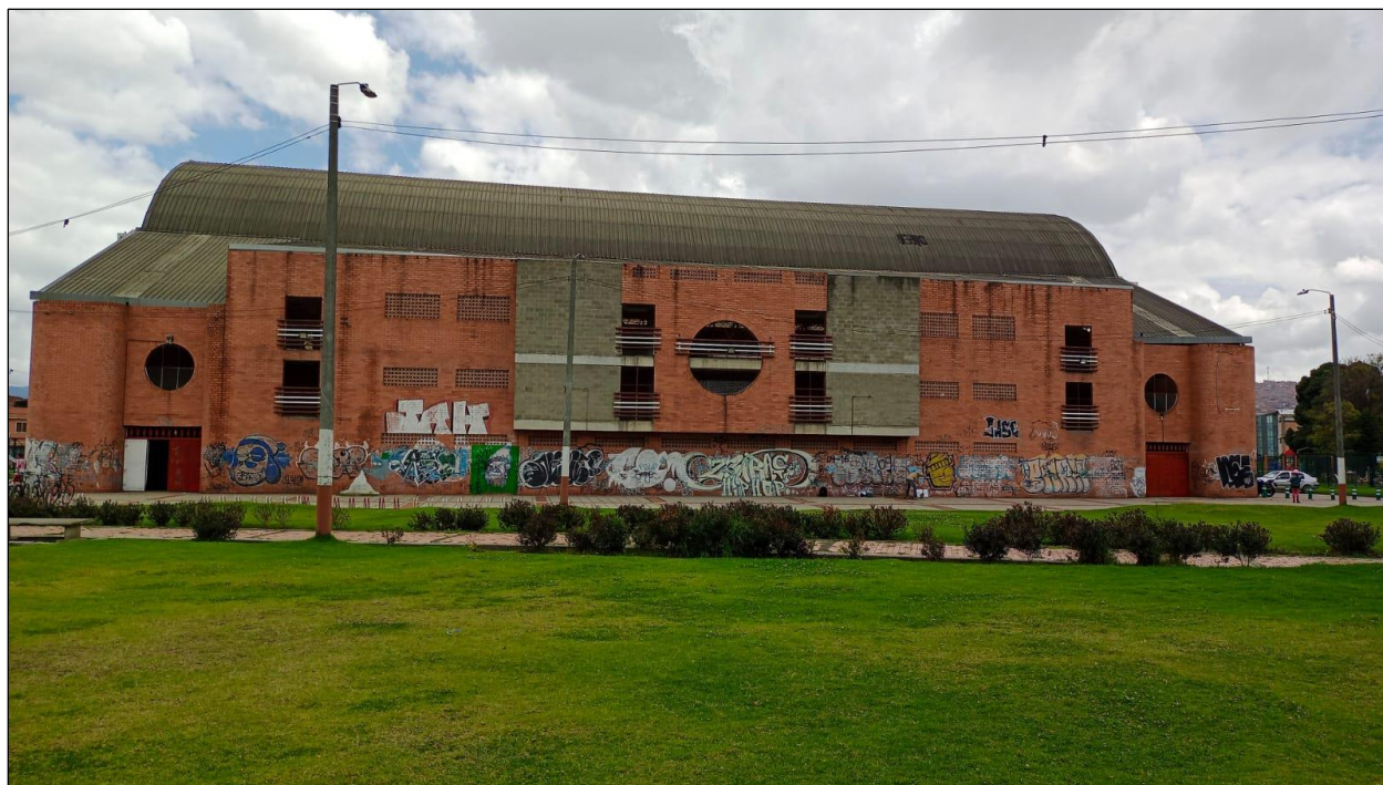
Ilustración 44 - Fachada lado occidente Coliseo León XIII.
