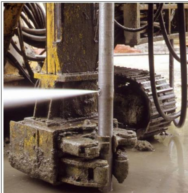
Ilustración 75 - Jet Groutin saliendo por tubería, fuente: Jet_GROUTING_Juan_Manuel_Fernandez.pdf
