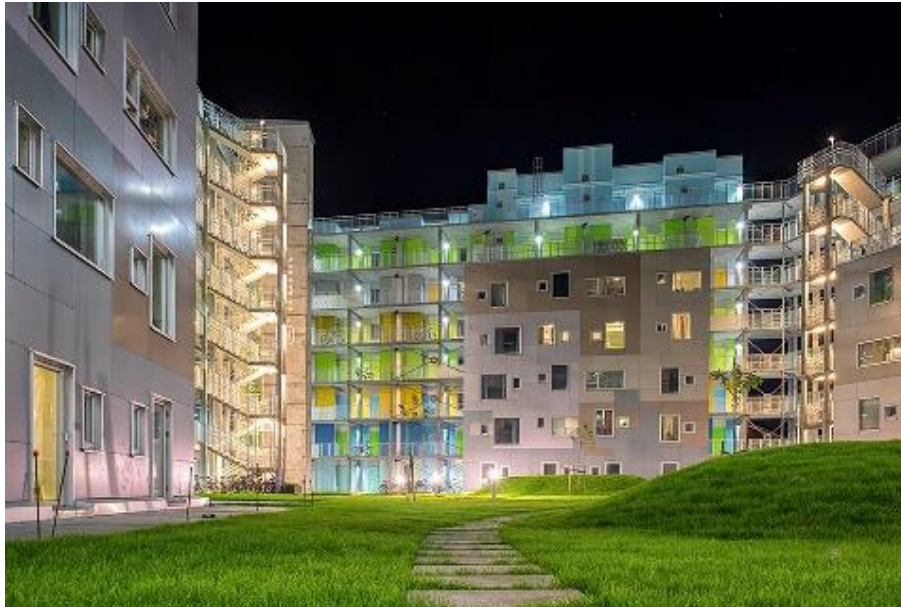
Figura 8. Fachada del proyecto
