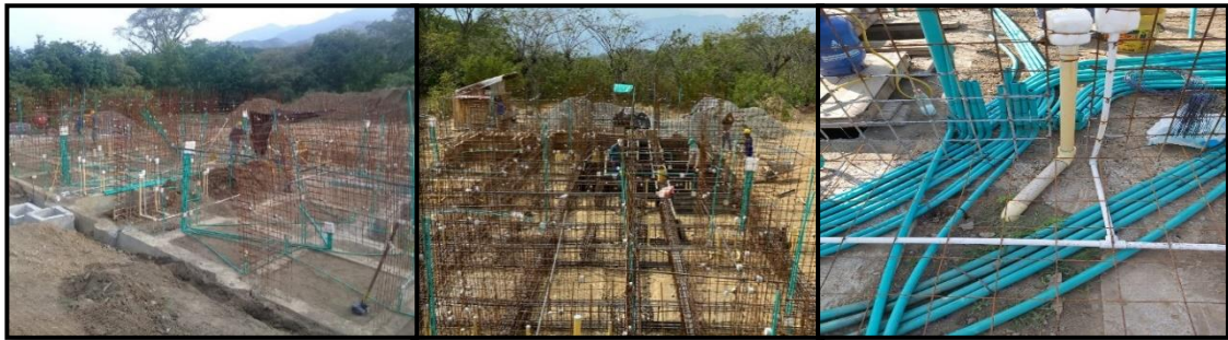
Figura 31. Ubicación y fijado, tubería eléctrica.
