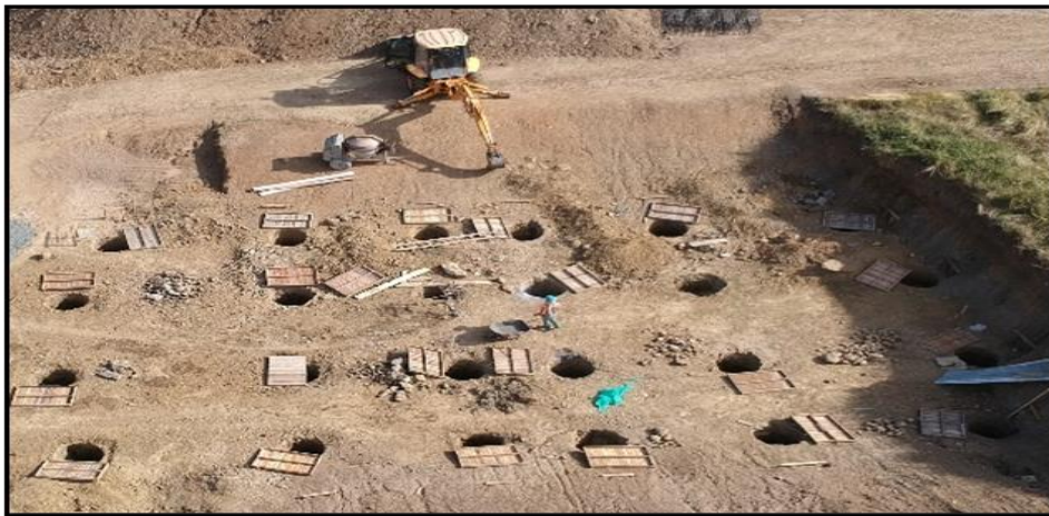
Figura 20. Finaliza la actividad de excavación, pilas de cimentación.
