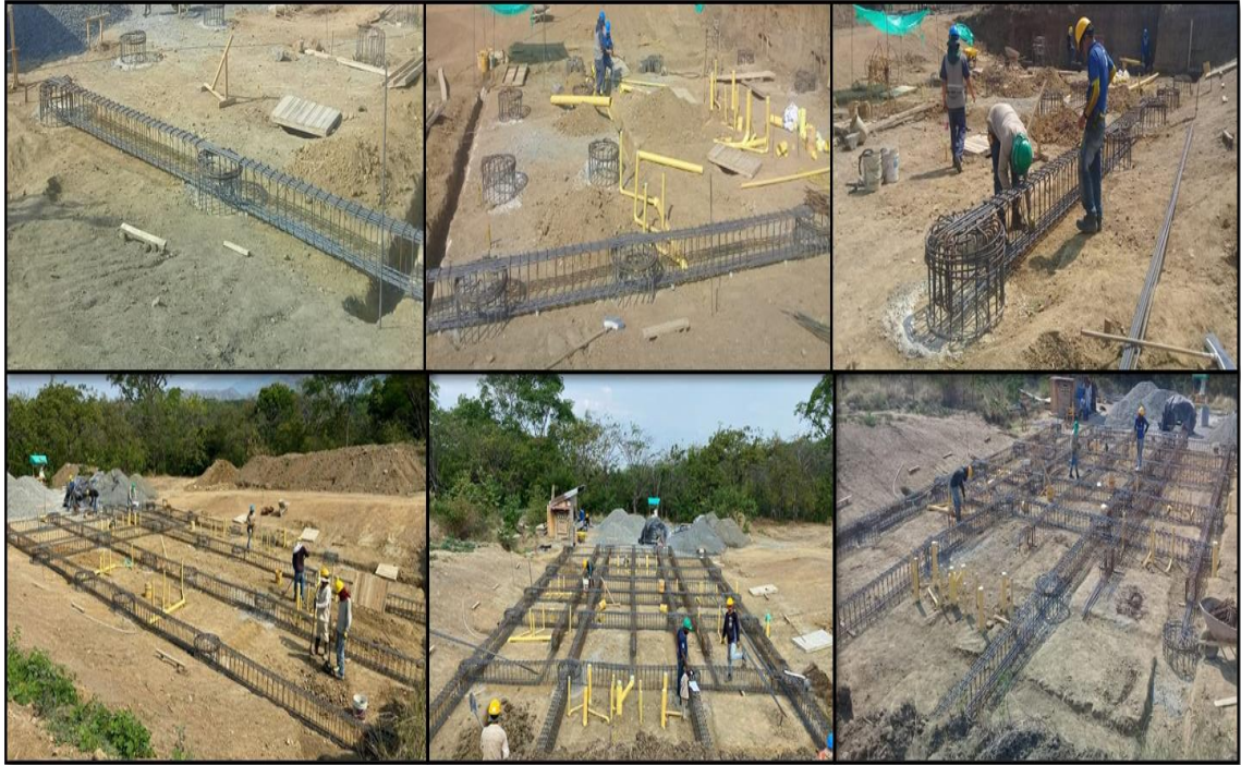
Figura 25. Armado de acero, vigas de cimentación.
