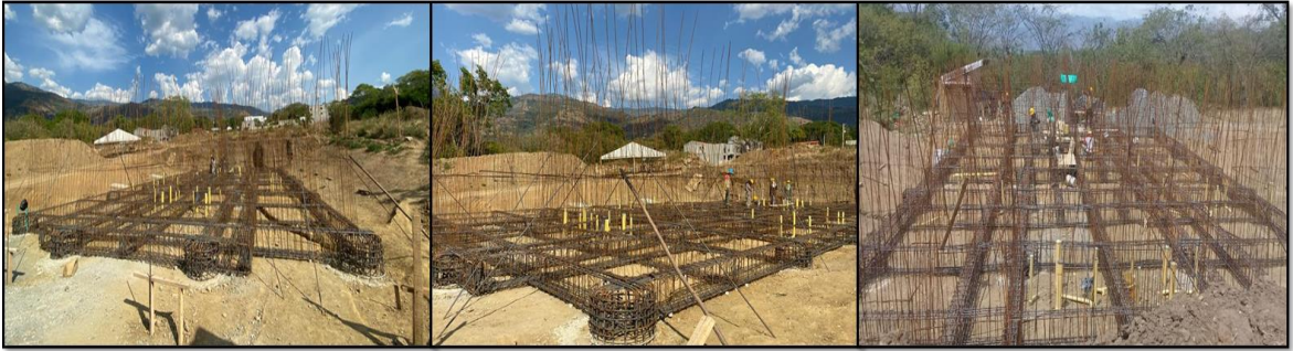
Figura 26. Amarre del acero longitudinal de muros.
