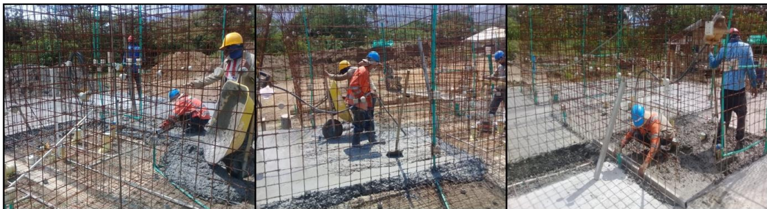
Figura 32. Mezclado y vaciado del concreto, losa de piso.
