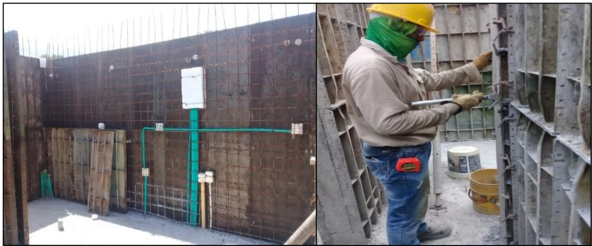
Figura 4. Encofrado de muros.
