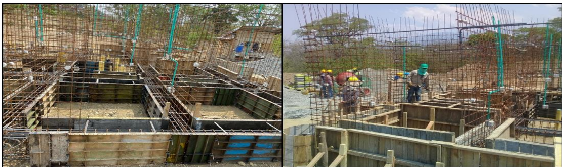
Figura 28. Encofrado, vigas de cimentación.
