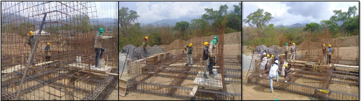
Figura 27. Amarre del acero transversal de muros.
