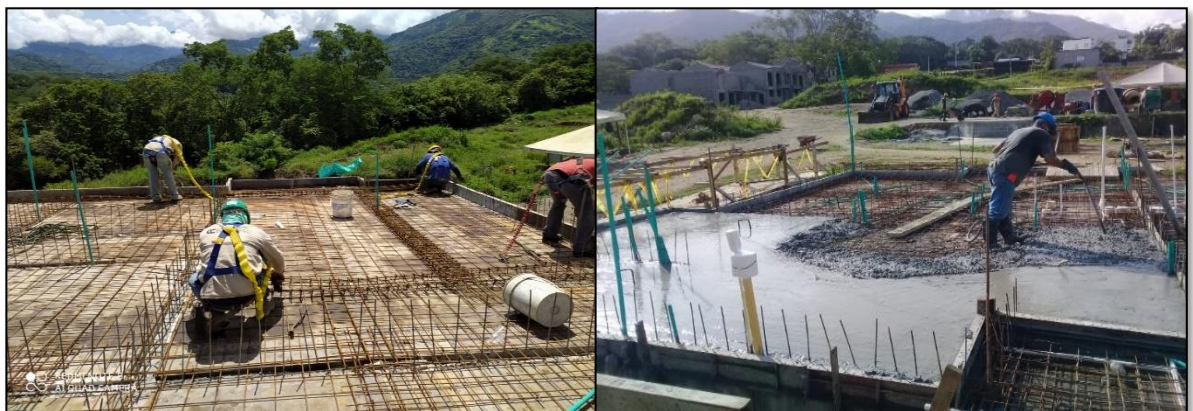
Figura 7. Fundición de placas.
