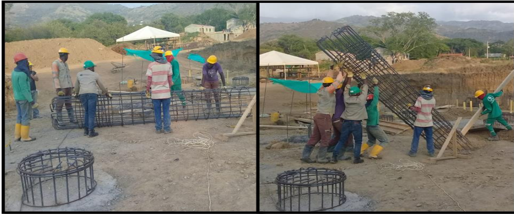
Figura 44. Acero de refuerzo, vigas de cimentación.
