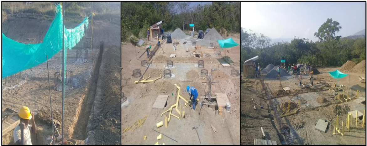
Figura 24. Instalación de tubería hidrosanitaria.
