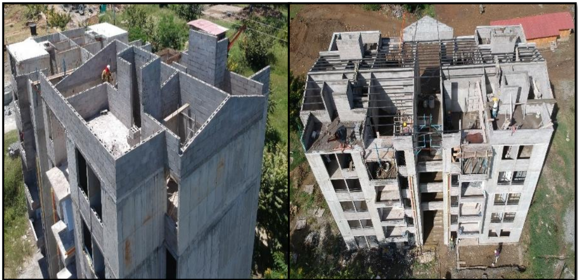
Figura 42. Construcción de cubierta.
