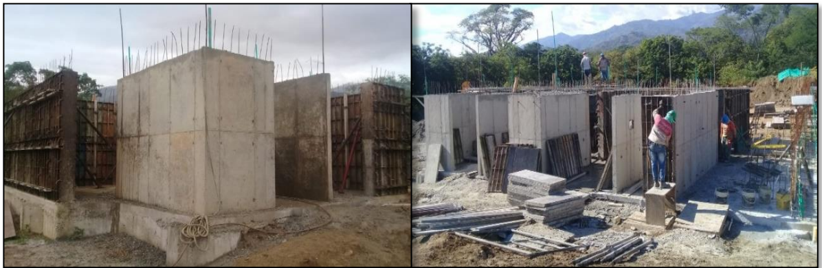
Figura 6. Desencofrado de muros.
