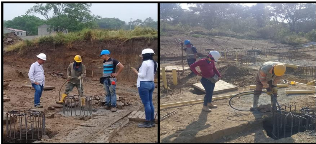
Figura 45. Vibrado del concreto.
