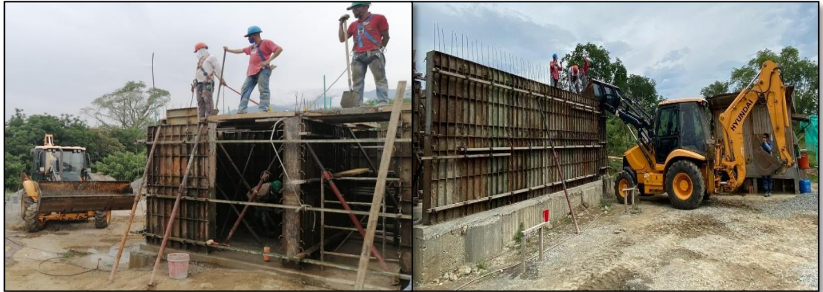
Figura 5. Fundida de muros.
