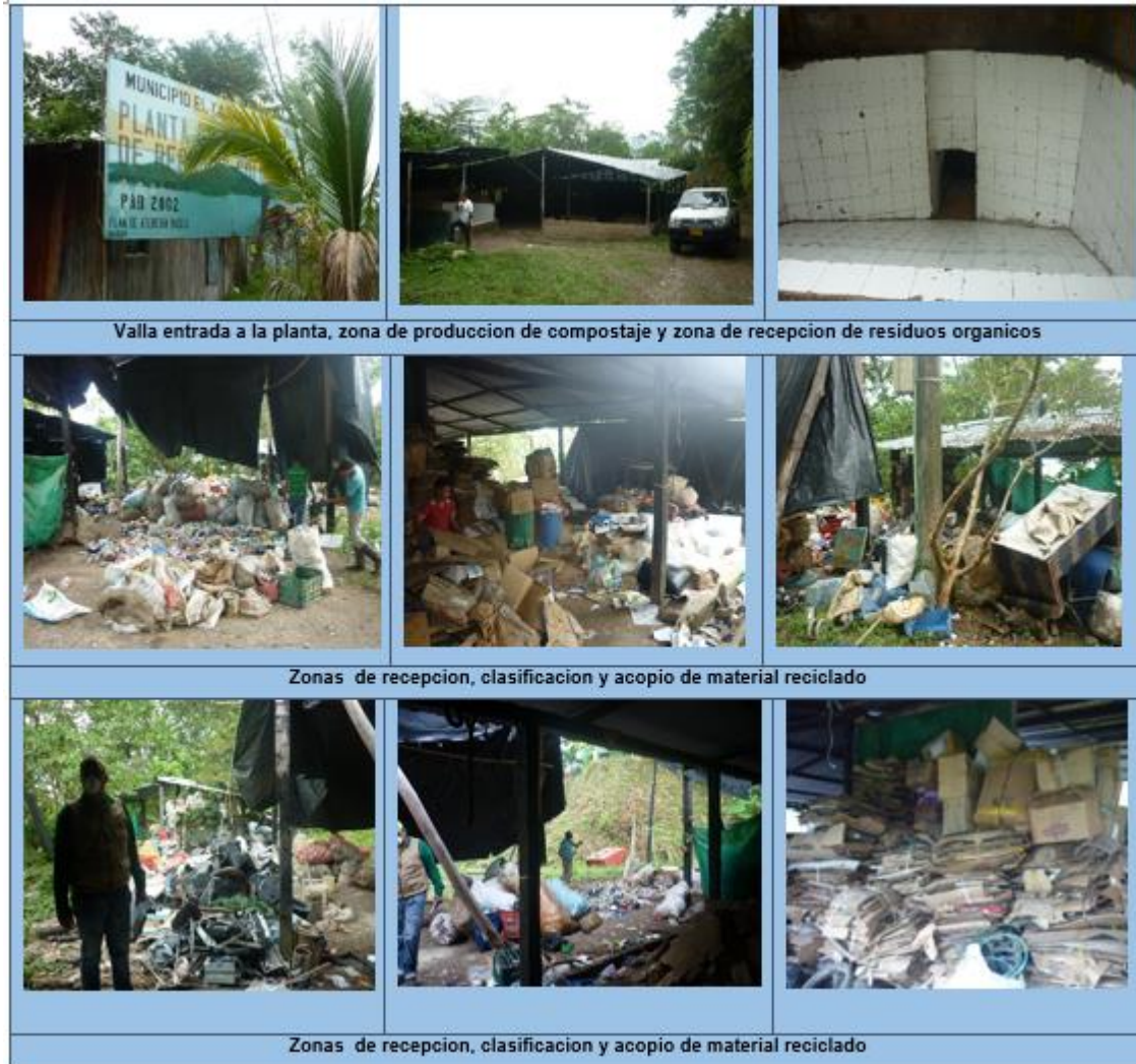
Figura 52. Imágenes. Planta de tratamiento de Residuos Solidos
