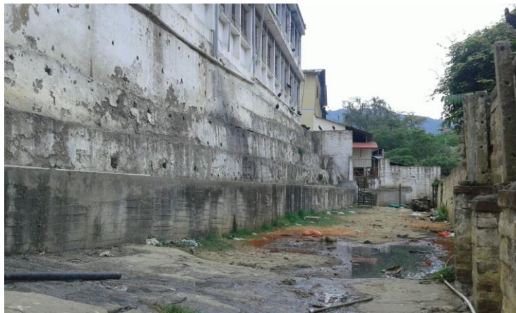
Figura 7. Parte baja. Humedad y foco de plagas. Aguas residuales vertidas al río.
