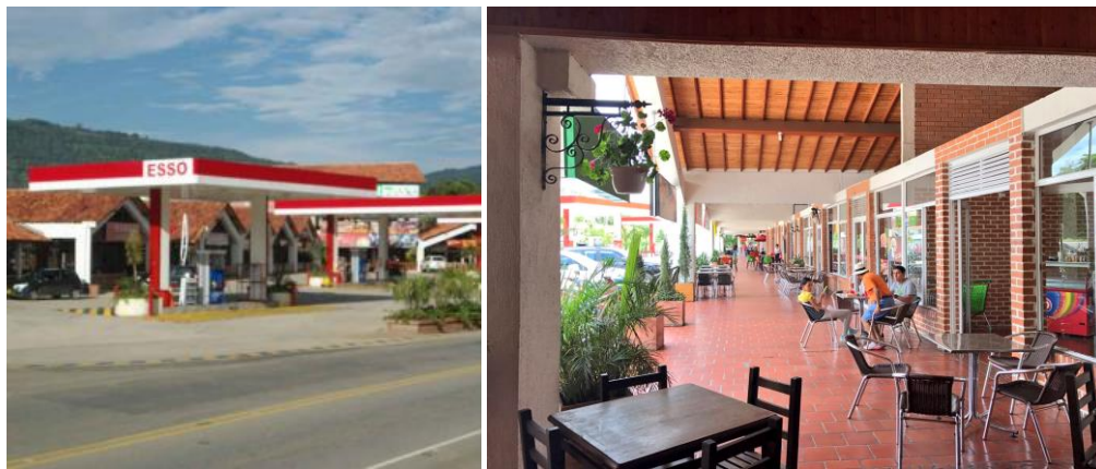
Figura 16. Estación de servicio La Isla.
