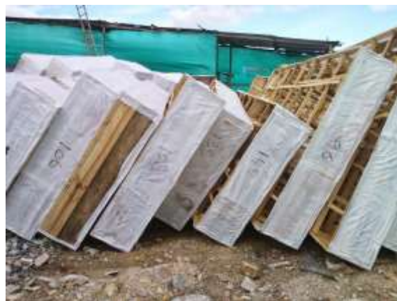
Ilustración 3. Caseton en lona sintética Fuente: Aserrío la montaña
