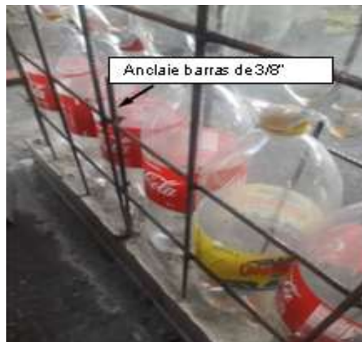
Ilustración 57. Anclajes para los módulos Fuente: propia
