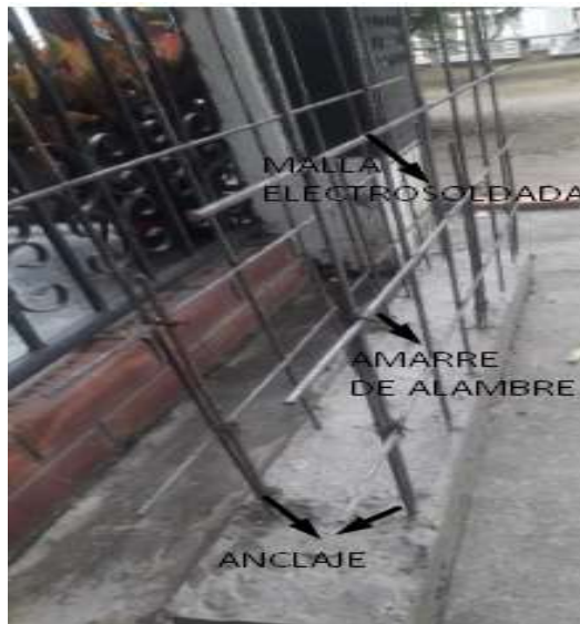
Ilustración 53. Anclaje de malla electrosoldada a los anclajes Fuente: propia
