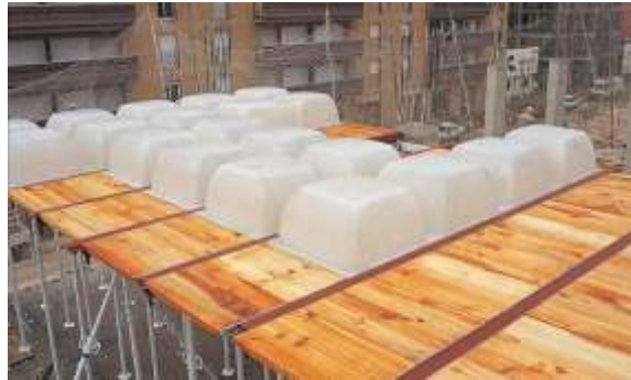
Ilustración 4. Casetón de PVC Fuente: Construmatica
