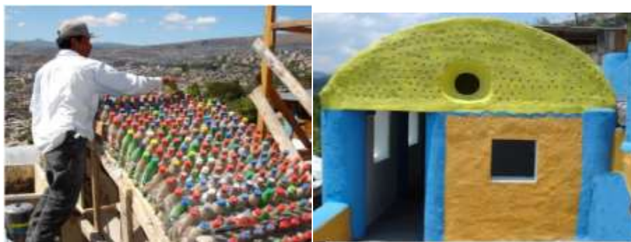
Ilustración 16. Sky Field House de Eco Tec en construcción el primer techo abovedado con botellas PET
