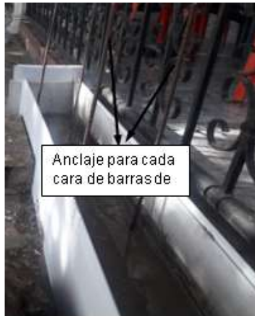
Ilustración 50. Anclaje del módulo para muros no estructurales Fuente: propia
