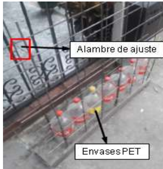
Ilustración 54. Ajuste del ancho de las mallas Fuente: Propia
