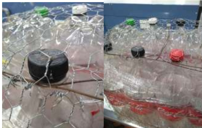
Ilustración 68. Casetón 12 daño generado por la carga Fuente: Propia
