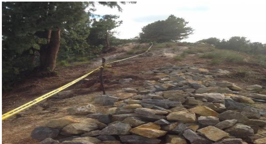
Fotografía 2. Muro de Cerramiento.
