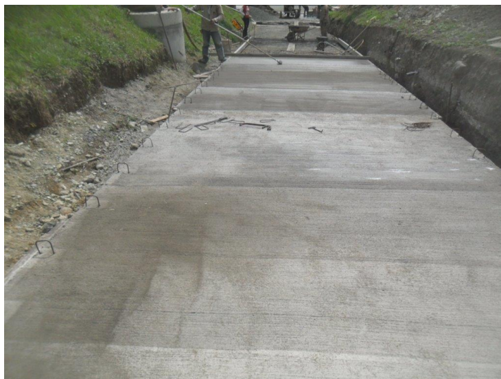
Figura 35. Escobado de capa de rodadura. Fuente: Elaboración propia
