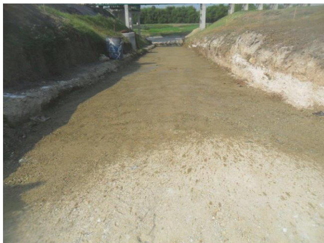
Figura 20. Humedad para compactación de sub-rasante. Fuente: Elaboración propia
