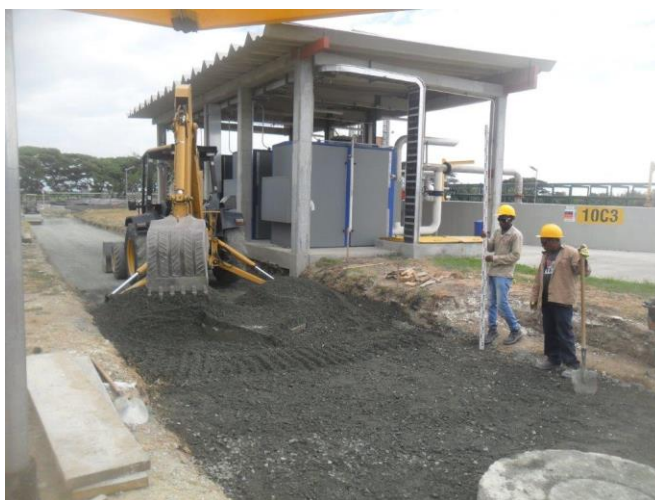
Figura 23. Esparcimiento de sub-base. Fuente: Elaboración propia
