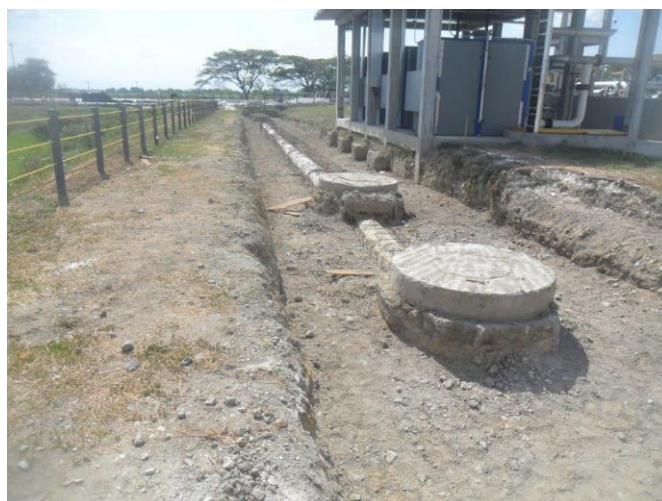
Figura 14. Excavación de tubería y recamaras existentes. Fuente: Elaboración propia
