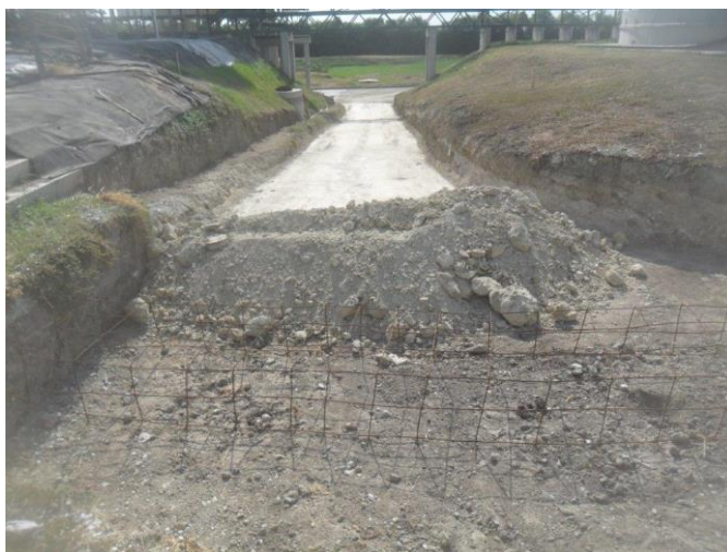
Figura 19. Relleno, perfilado y compactación de sub-rasante. Fuente: Elaboración propia
