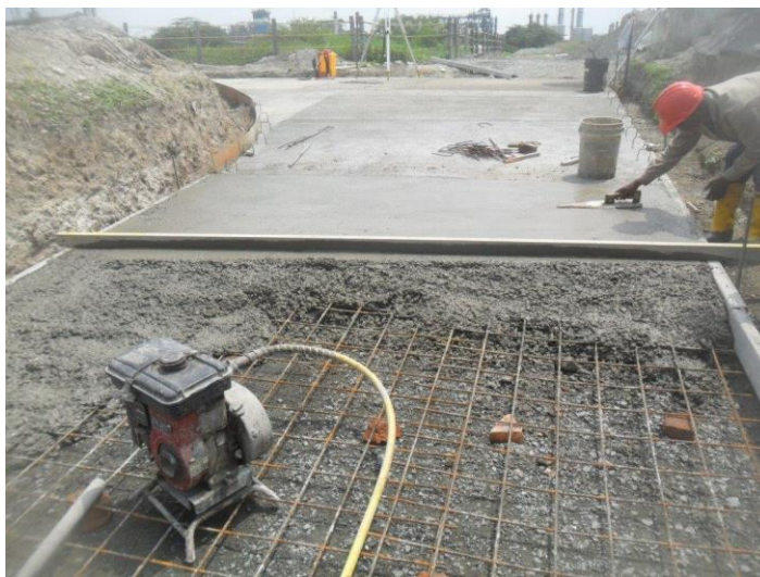
Figura 33. Codal y Pla tachado de concreto. Fuente: Autor Elaboración propia
