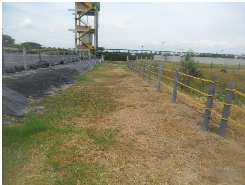
Figura 8. Vía con capa vegetal. Fuente: Elaboración propia
