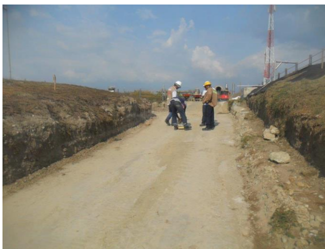
Figura 21. Sub-rasante realizando ensayo de densidad. Fuente: Elaboración propia
