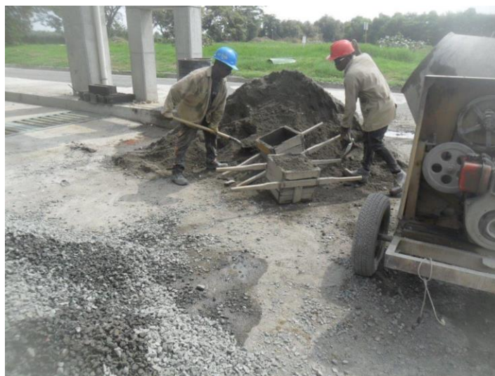
Figura 28. Dosificación volumétrica de concreto en sitio. Fuente: Elaboración propia
