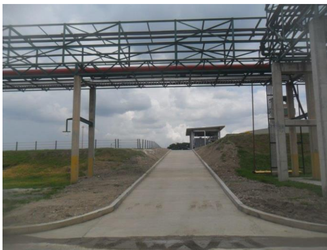
Figura 40. Capa de rodadura llegando a vía existente. Fuente: Elaboración propia
