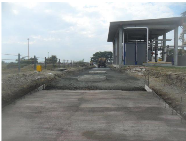
Figura 24. Humedeciendo para compactación de sub-base. Fuente: Elaboración propia
