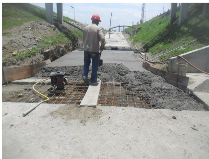
Figura 30. Vaciado de concreto. Fuente: Elaboración propia
