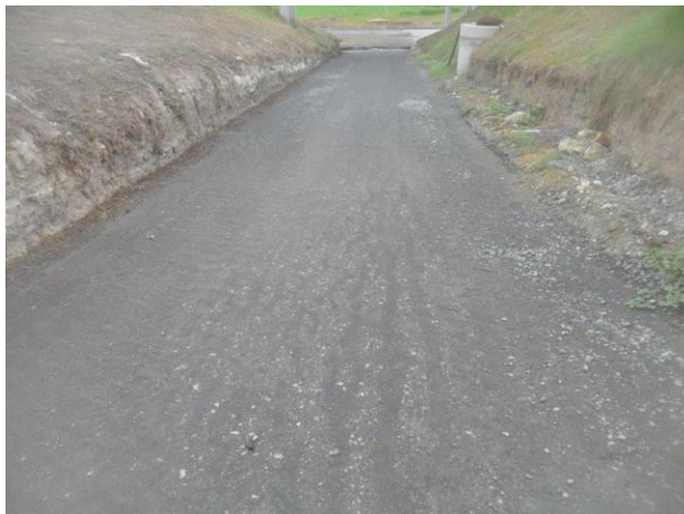
Figura 26. Material de Sub-base seriado y compactado. Fuente: Elaboración propia
