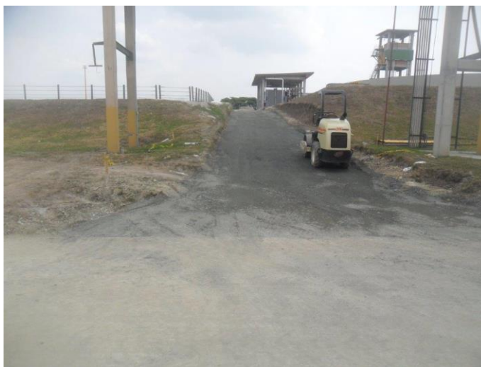
Figura 25. Compactación de sub-base. Fuente: Elaboración propia
