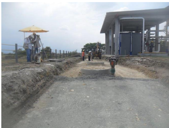
Figura 22. Conformación de sub-base. Fuente: Elaboración propia
