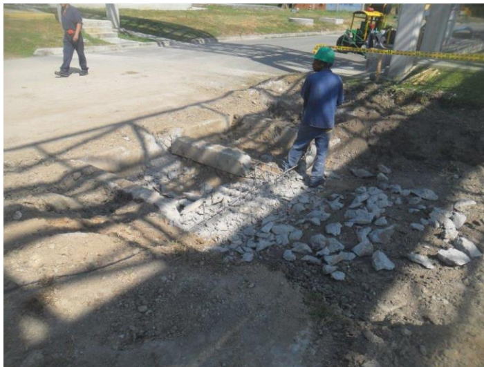
Figura 17. Demolición de elementos de concreto hallados en el área de vía. Fuente: Elaboración propia
