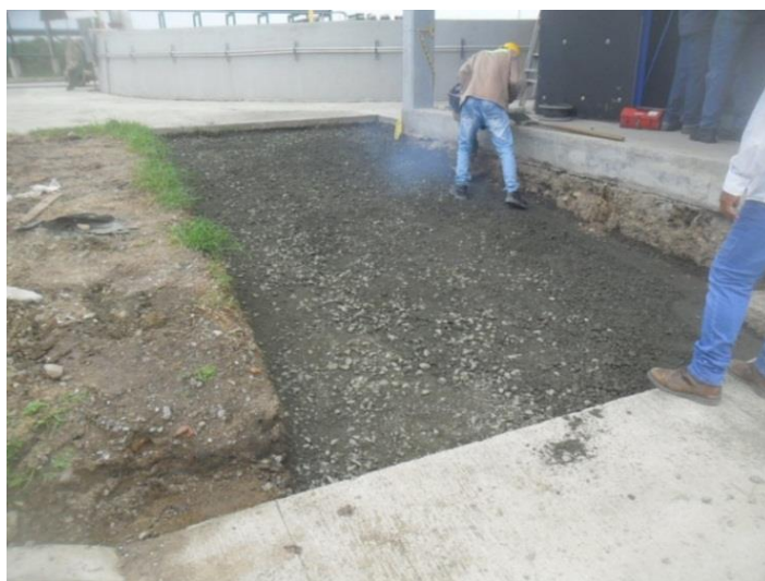
Figura 34. Construcción de rampas, paso al área de tanques. Fuente: Elaboración propia
