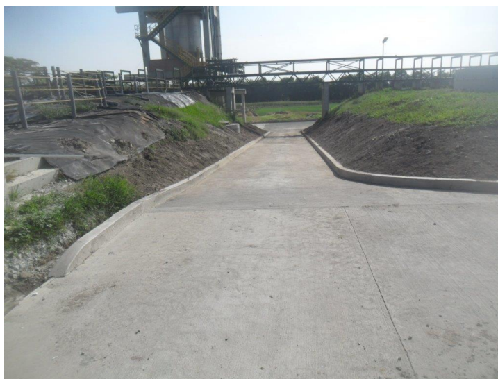
Figura 38. Conformación de taludes. Fuente: Elaboración propia
