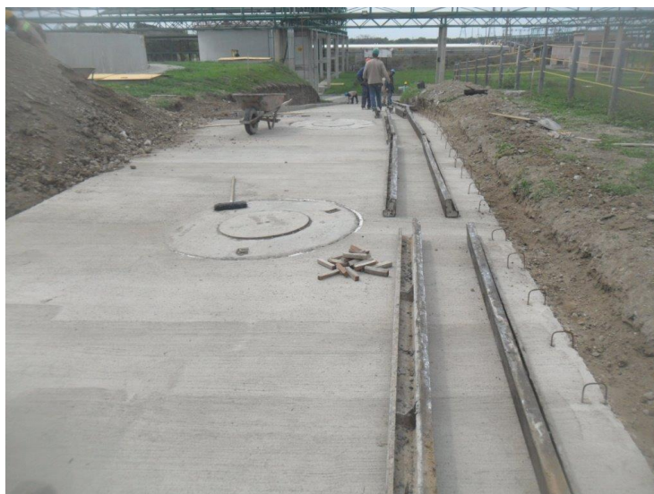
Figura 36. Encofrado de cordones. Fuente: Elaboración propia
