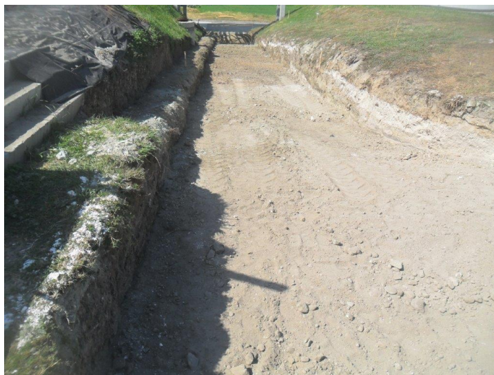
Figura12. Excavación del terreno. Fuente: Elaboración propia
