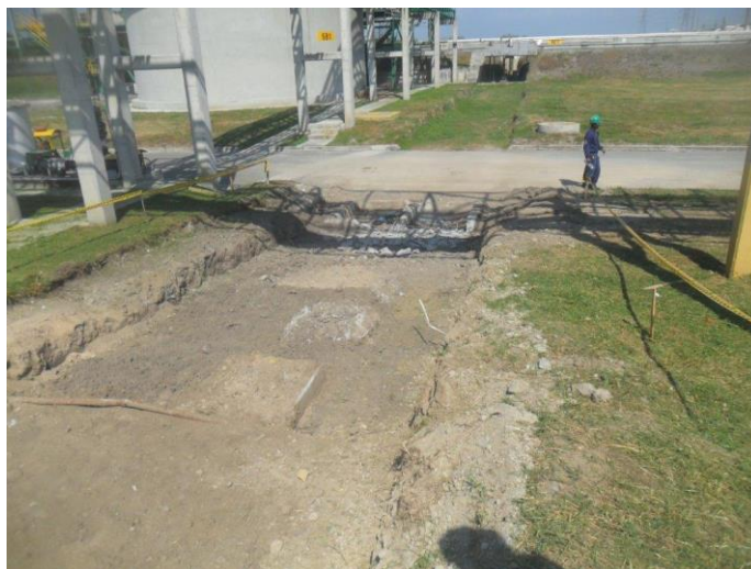
Figura13. Excavación y perfilada de vía. Fuente: Elaboración propia
