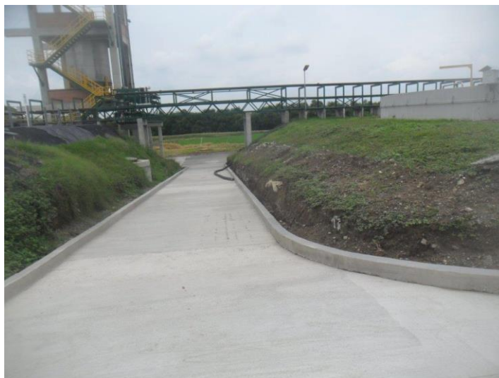
Figura 37. Cordones ejecutados. Fuente: Elaboración propia
