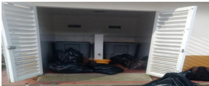
Figura 5. Vista interna de la Unidad de Almacenamiento Temporal del Campus Loma Linda.
