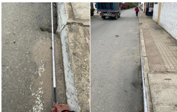
Figura 7. Levantamiento de medidas en predio para proceso de asignación de nomenclatura. Fuente: Autoría propia
