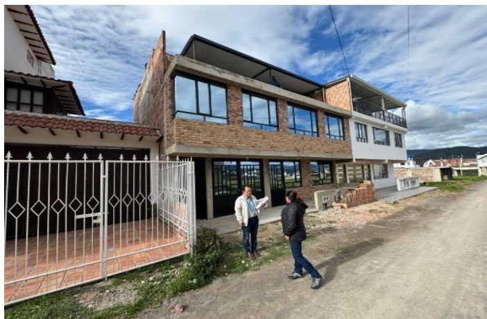
Figura 4. Inspección técnica de control urbano en zona urbana del municipio de Tibasosa. Fuente: Autoría propia.
