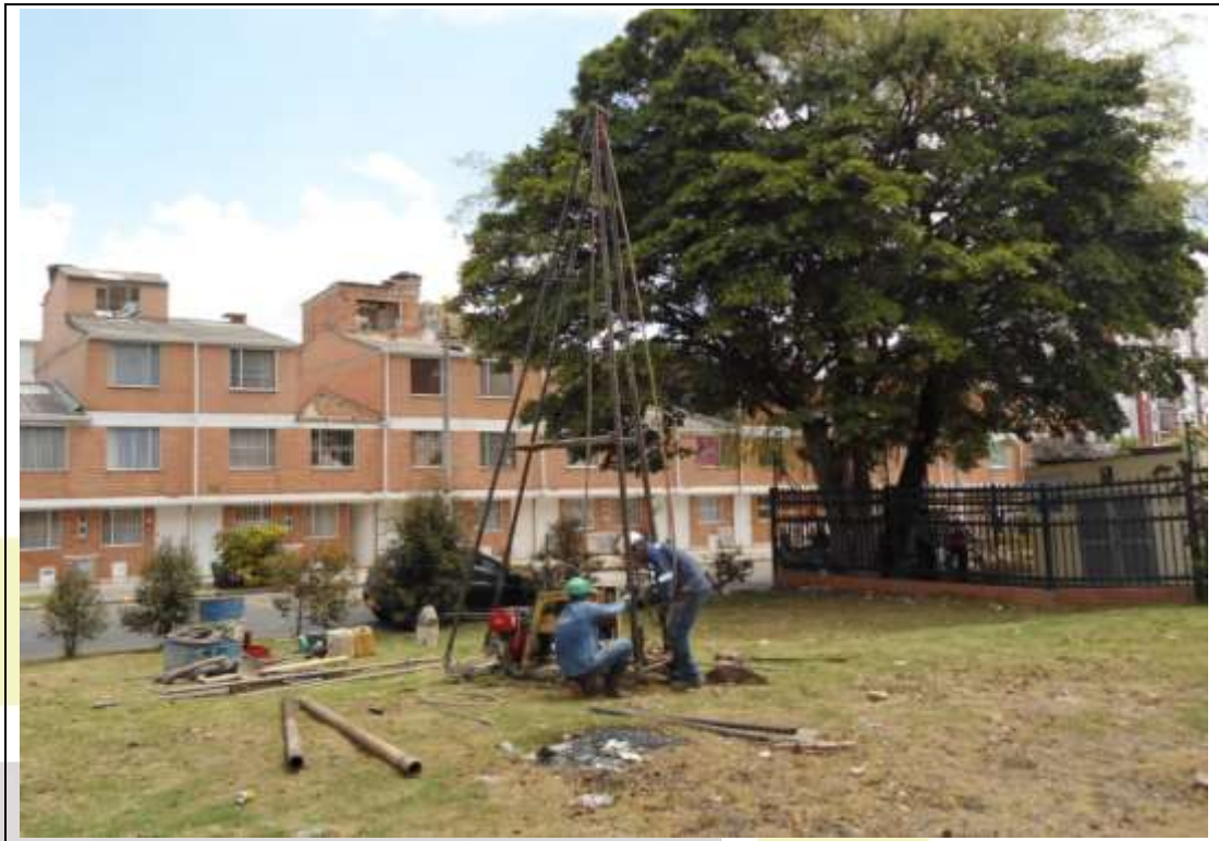
Figura 6. Ejecución Sondeo 1.
