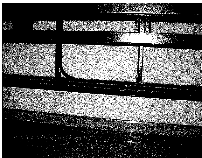
Fotografía 2. Mesas por debajo después del cableado
