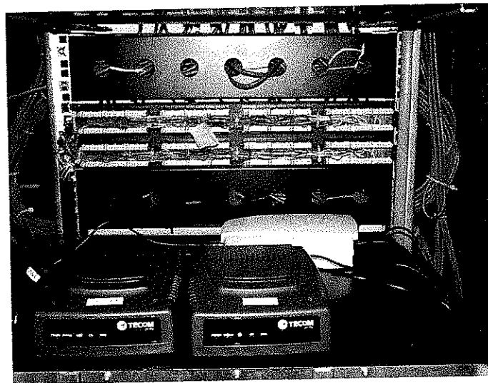
Fotografía 21. Celufijos movistar y Comcel conectados a la planta telefónica
