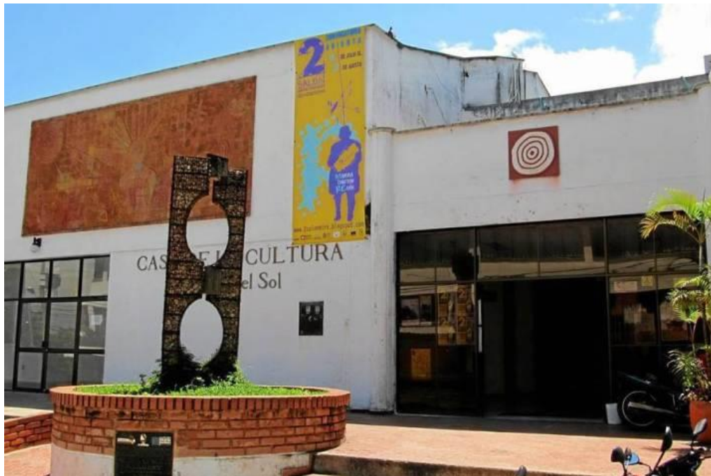
Figura 10. Fachada de la Casa de la Cultura Piedra del Sol.
