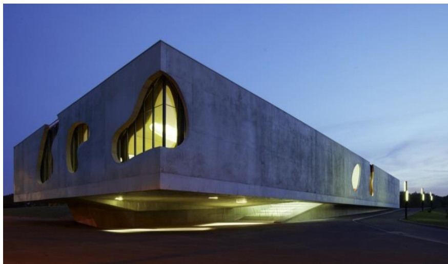
Figura 30. Fotografía exterior esquinera del Conservatorio de la música de Maizières.
