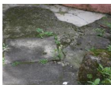
SINTOMA EN ANDEN SOBRE LA CALLE 104 A (5) Descripción del síntoma: Desquebrajamiento y hundimiento del mortero, aparición de vegetación.
