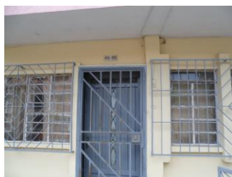
VISTA GENERAL DE LA FACHADA SOBRE LA CALLE 104 A
