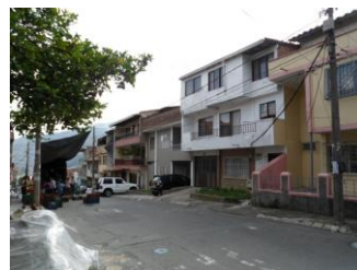
VISTA GENERAL DE LA FACHADA SOBRE LA CALLE 104 A
